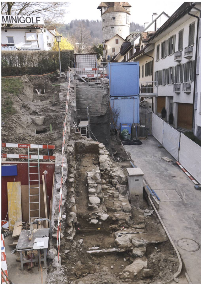
Abb. 46 Zug, Löberensteig. Gesamtansicht der Grabungssituation. Im Vordergrund Reste der Grabengegenmauer und einer älteren Löberensteig-Treppe, im Hintergrund der Kapuzinerturm. Blick nach Südosten.
