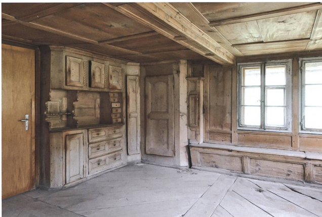
Abb. 3 Die Stube wurde 1780/90 ungewöhnlich repräsentativ ausgebaut (Zustand vor dem Umbau). Die baugeschichtlich wertvollen Fenster aus dem 19. Jahrhundert konnten erhalten und ertüchtigt werden.
