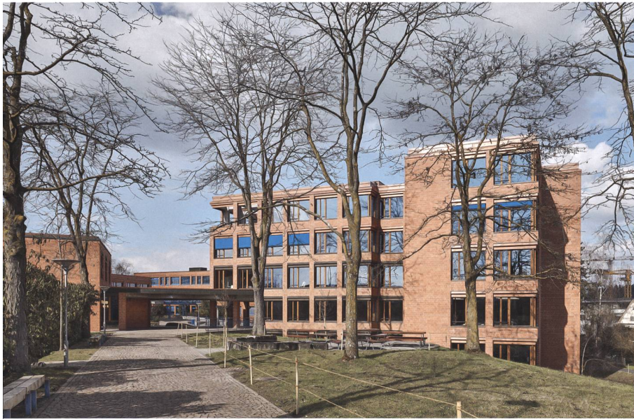
Abb. 1 Cham, Schulhaus Röhrliberg. Aussenansicht nach Umbau mit Aufstockung.
