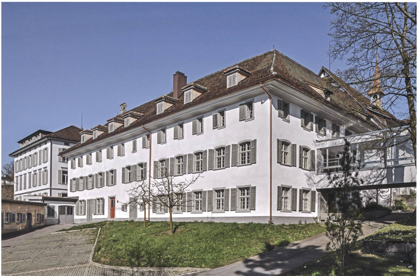
Abb. 1 Am denkmalgeschützten Kloster musste der schadhafte Fassadenputz ersetzt werden. Mit dem sogenannten Wormserputz stand ein prägendes Element der Zeit um 1900 fest, welches als Vorbild für die Fassadensanierung diente.
