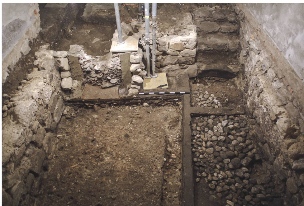
Abb. 51 Zug, Unteraltstadt 27. Blick in den freigelegten Halbkeller mit der Treppe in der Südostecke.
