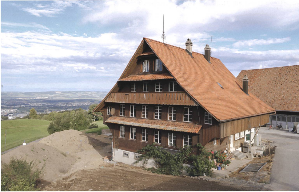
Abb. 24 Menzingen, Wulfligen 2. Das Wohnhaus zum Zeitpunkt der Bauuntersuchung, Blick nach Nordwesten.
