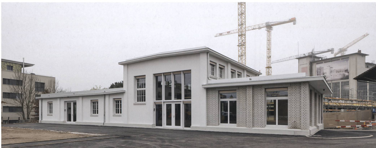
Abb. 17 Cham, Papieri-Areal, ehemalige Lokremise. Südansicht nach der Sanierung. Der östliche Anbau im Sichtmauerwerk ersetzt einen ehemaligen Garagenanbau.
