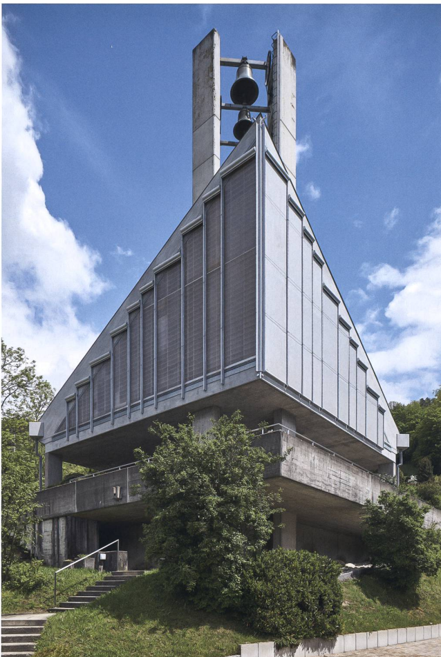
Abb. 36 Walchwil, Seckistrasse, Reformierte Kirche. Ansicht von Südwesten, nach der Betonsanierung im oberen Bereich des Gebäudes.
