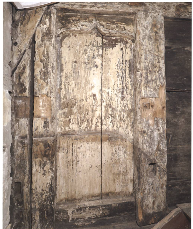
Abb. 39 Zug, Neugasse 17. Kernbauzeitliche Türöffnung mit Kielbogen, fotografiert aus dem ehemaligen Rauchküchenbereich.
