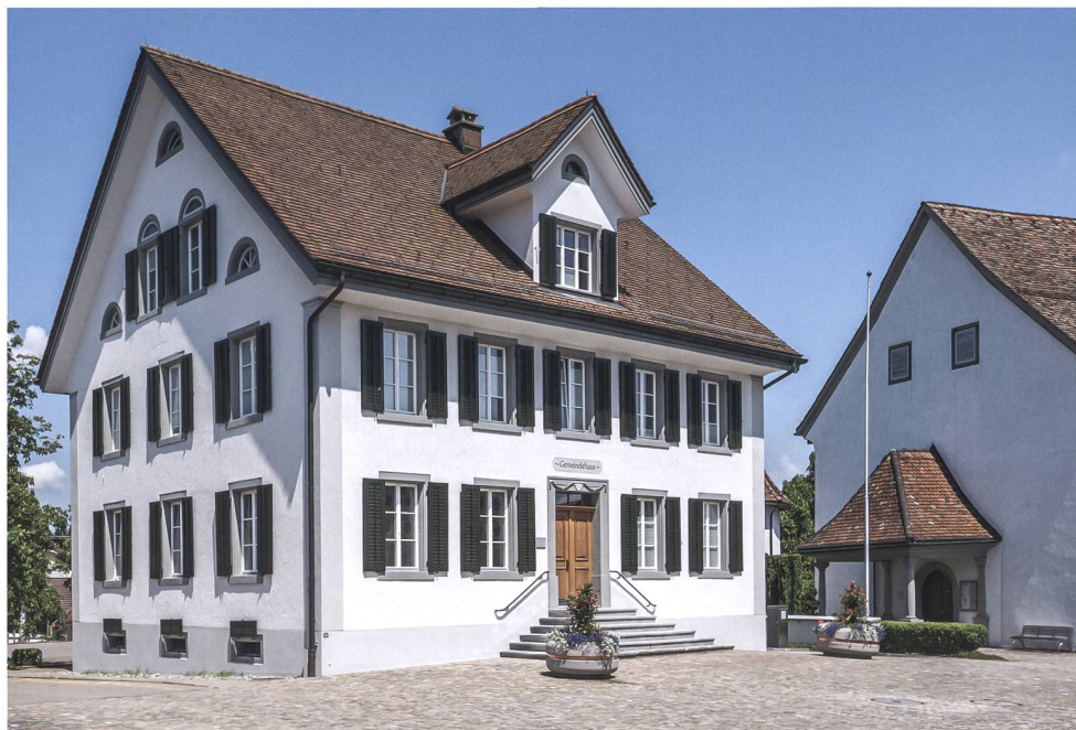
Abb. 25 Neuheim, Dorfplatz 5, Gemeindehaus, ehemaliges Schulhaus. Das Gemeindehaus von Neuheim im neuen Farbenkleid nach der Fassadenrenovation.
