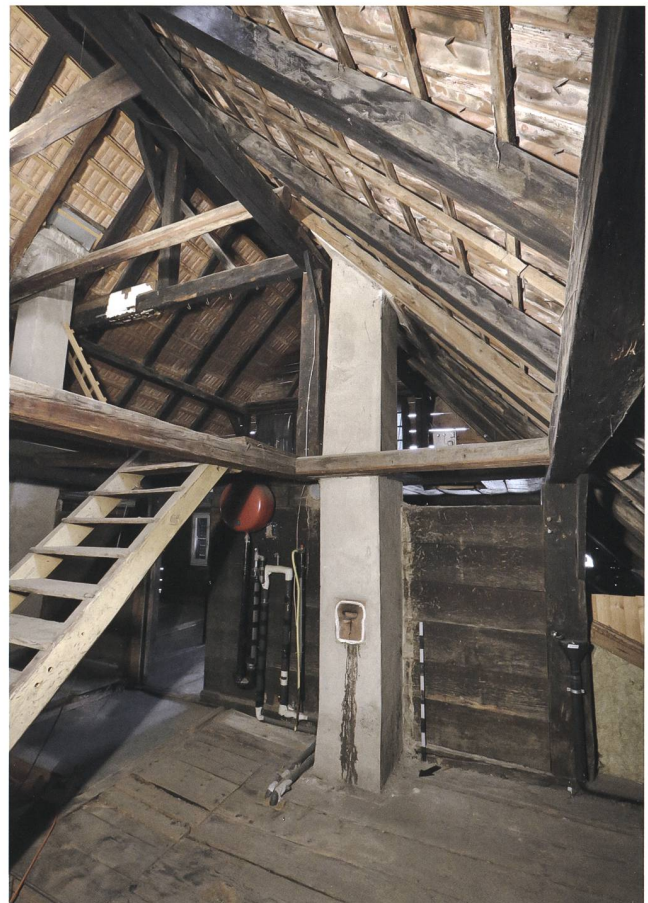
Abb. 32 Steinhausen, Bahnhofstrasse 22/24/24a. Stehender Dachstuhl von 1638. Blick nach Südosten.
