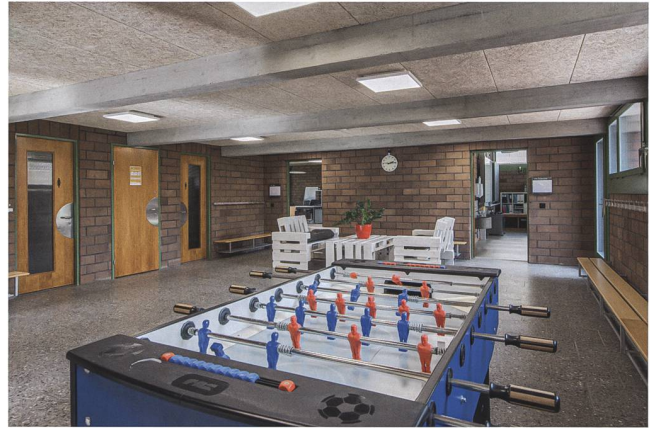
Abb. 4 Die Fenster wurden sorgfältig nachgebaut (rechter Bildrand). Kaum wahrnehmbar ist die neue Behindertentoilette stimmig zwischen zwei bestehende Türen eingefügt worden (linker Bildrand).
