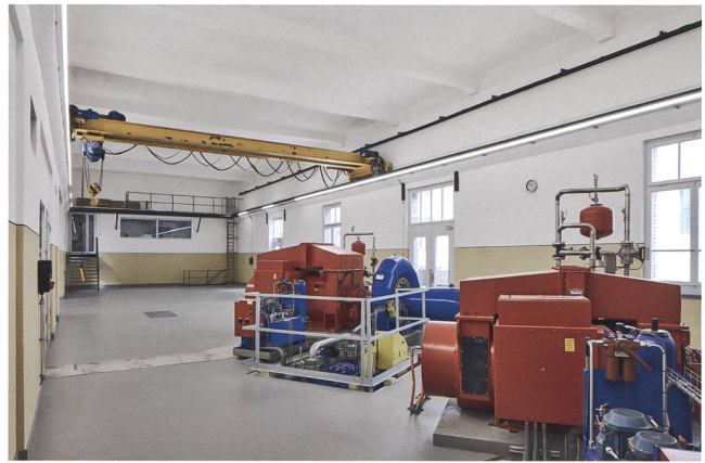
Abb. 3 Baar, Haldenstrasse 7, «Zentrale 3». Blick nach Westen zur Kommandozentrale. Im Vordergrund die neuen Turbinen in der sorgfältig sanierten Maschinenhalle mit den nach Befund gestrichenen Wänden.
