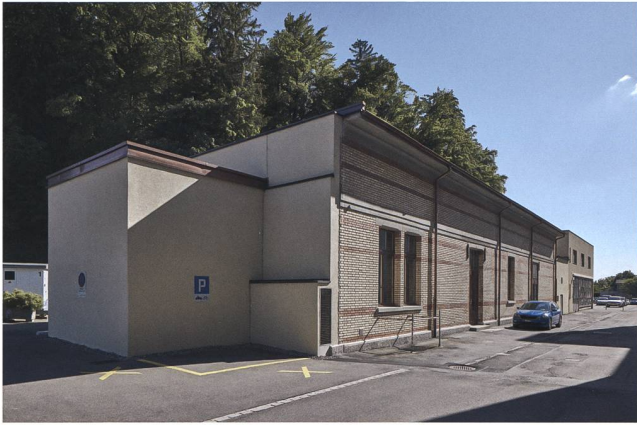
Abb. 2 Baar, Haldenstrasse 7, «Zentrale 3». Ansicht von Ost mit Sicht auf die gereinigte Sichtbacksteinfassade und die restaurierten Putzflächen.
