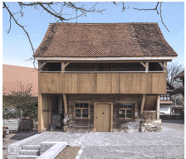
Abb. 19 Hünenberg, Chamau 4, Speicher. Südansicht, nach der Sanierung.
