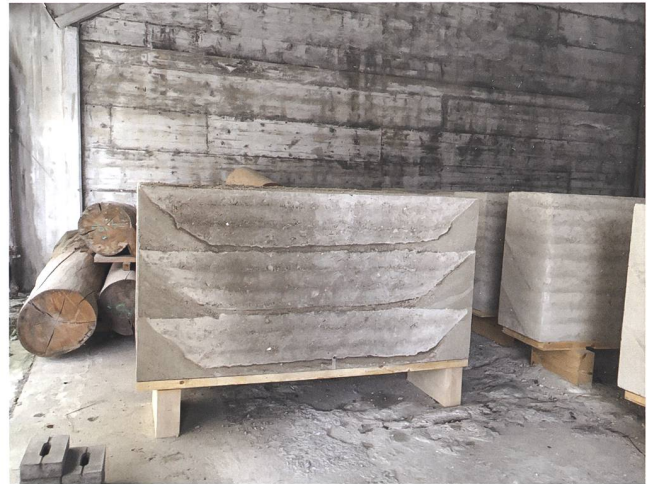
Abb. 2 Die ausgeschalteten Stampflehmelemente wurden zwischengelagert und danach auf den Bauplatz beim Ziegeleimuseum Cham transportiert.
