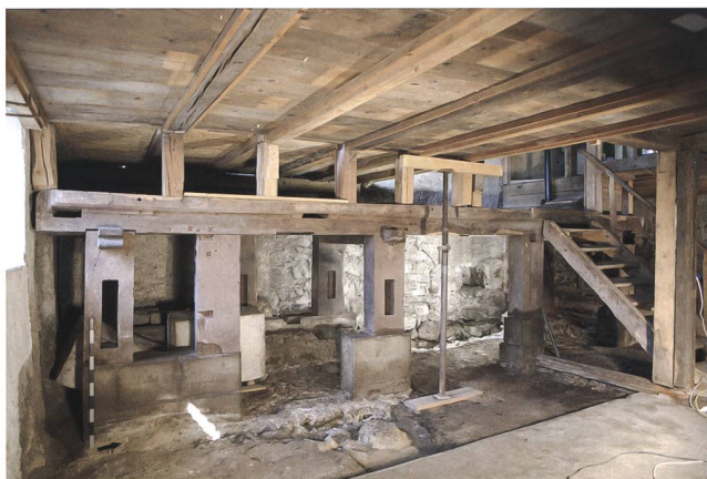
Abb. 26 Oberägeri, Alosenstrasse 3, Mühle. Das in Teilen überlieferte Mühlgerüst von 1802 im Erdgeschoss des Hauses.
