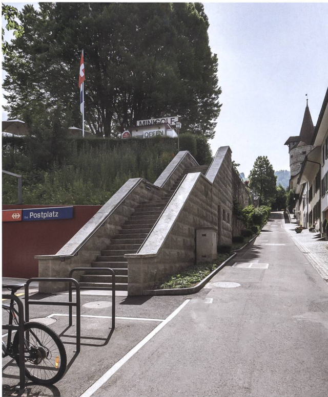
Abb. 45 Zug, Schanzengraben, Löberensteig. Die renovierte Treppenanlage mit den aufwändig wiederhergestellten Sandsteinbrüstungen.
