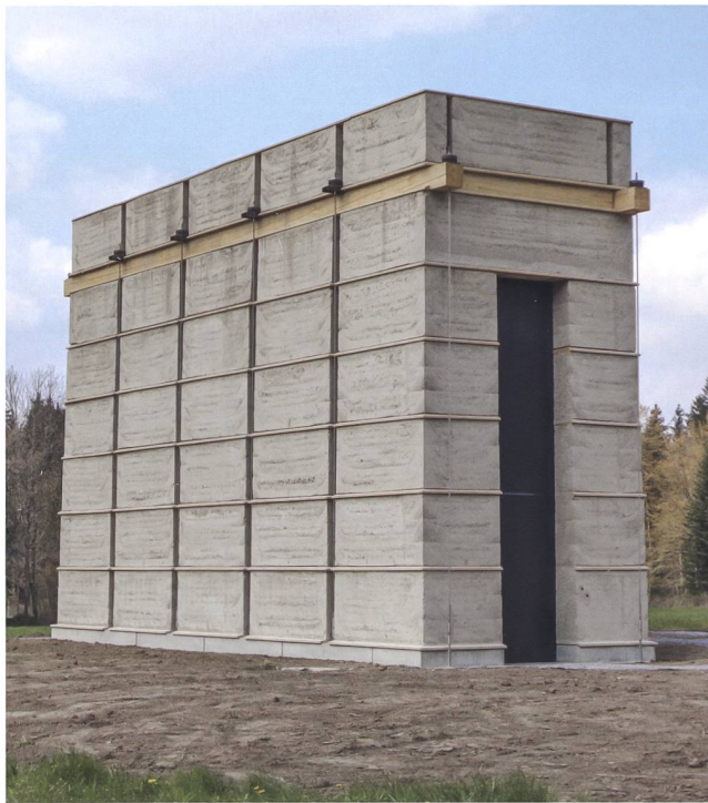
Abb. 3 Der Stampflehturm am Tag seiner Einweihung am 17. April 2021. Das hohe Eingangstor ist durch eine aufklappbare Metalltür verschliessbar.
