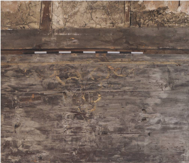
Abb. 40 Zug, Neugasse 17. Detail der Bohlenwand im «Oberstübli» mit Rankenmalerei. Erkennbar ist die Erhöhung des Raums im Zuge der Fachwerkaufstockung von 1605/06.
