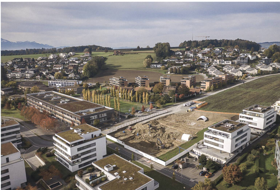
Abb. 11 Cham, Eichmattstrasse 34 und 36, Eichmatt III. Blick über den Bauperimeter gegen Westsüdwest. Links das Eichmattschulhaus, unten links ein (kleiner) Teil der Eichmatt-II-Überbauung, hinter der Baustelle die fächerförmig angeordnete Überbauung der Huobweid, im Hintergrund bewaldet das Langholz und der Chnoden. Im vorderen Teil der Baustelle wird bereits bis auf den anstehenden Molassefels abbaggert. In der Mitte ist einer der Grabenzüge freipräpariert und wird dokumentiert. Zwei Grabungszelte und Plastikplanen schützen weitere Befunde.
