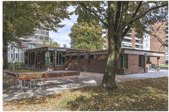
Abb. 2 Idyllisch eingebettet liegt das Kleinschulhaus Alpenblick zentral zwischen den Hochhäusern und ist jetzt wieder fachgerecht instand gestellt.
