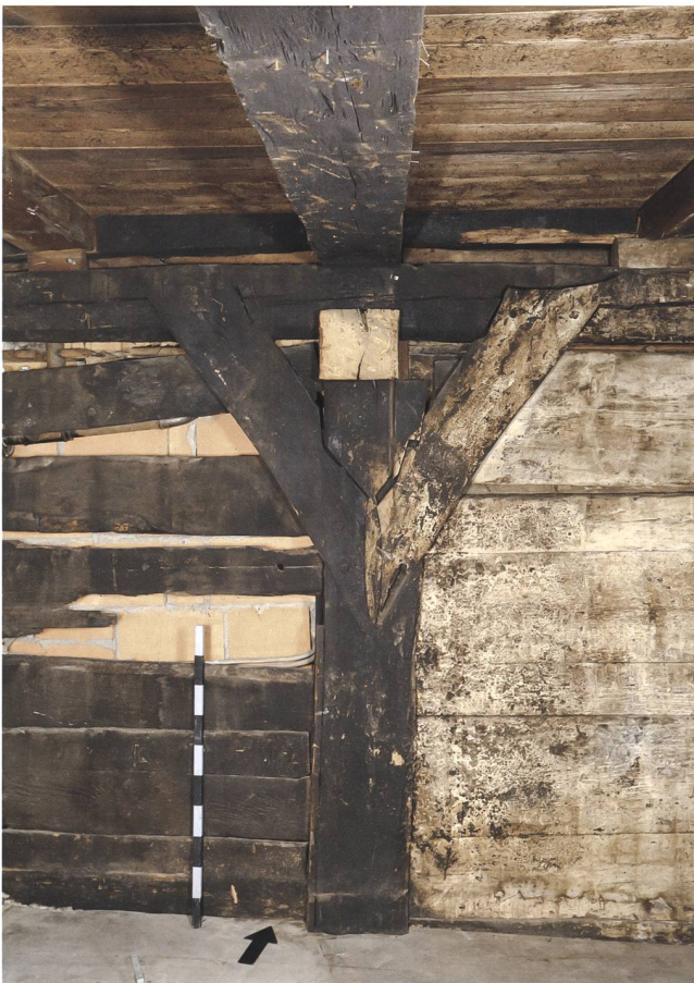
Abb. 31 Steinhausen, Bahnhofstrasse 22/24/24a. Mittelständer mit Kopfstreben in der Südfassade des Kernbaus von 1465. Blick nach Norden.
