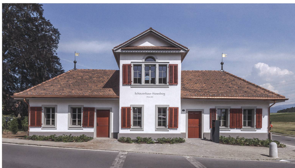
Abb. 20 Hünenberg, Wart, ehemaliges Schützenhaus. Ansicht von Westen, nach der Sanierung.
