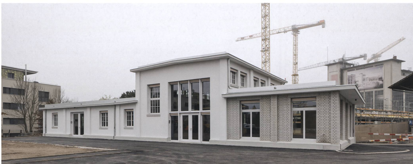
Abb. 17 Cham, Papier-Areal, ehemalige Lokremise. Südansicht nach der Sanierung. Der östliche Anbau im Sichtmauerwerk ersetzt einen ehemaligen Garagenanbau.
