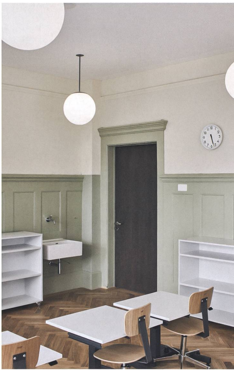
Abb. 3 Schulzimmer mit historischem Täfer sowie Tür mit historischem Rahmen und neuem Türblatt.
