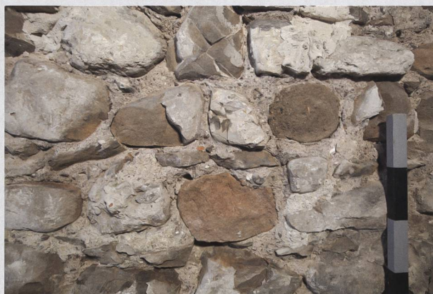
Zug, Unteraltdstadt 22. Brandgeschädigte Maueroberfläche. Die rötlich-braune Verfärbung der Steine und die abgeplatzten Steinhäupter zeugen von einer enormen Hitzeeinwirkung.
