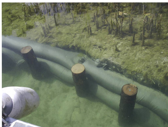
Abb. 9 Seit 1997 ergreift der Kanton Zug bauliche Massnahmen zum Schutz der Schilfpflanzen und von archäologischen Fundschichten im untiefen Wasser. Mittels Holzpfehlen wird die Kliffkante der Flachwasserzone stabilisiert, um die Erosion zu stoppen.
