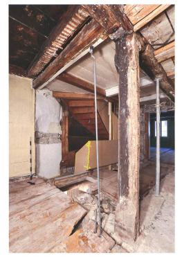
Abb. 3 Deckenbretter und Reste des rückwärtigen Steinbaus von 1448. Unterzug und Stütze von 1709 als Ersatz der gemauerten Wand. Blick nach Westen.
