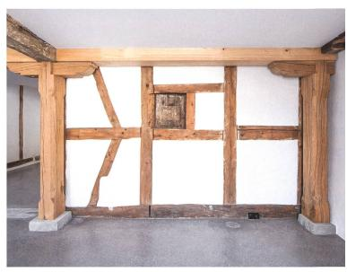
Abb. 4 Erdgeschoss. Fachwerkwand mit neuen Stützen und Unterzug nach der Sanierung 2020.
