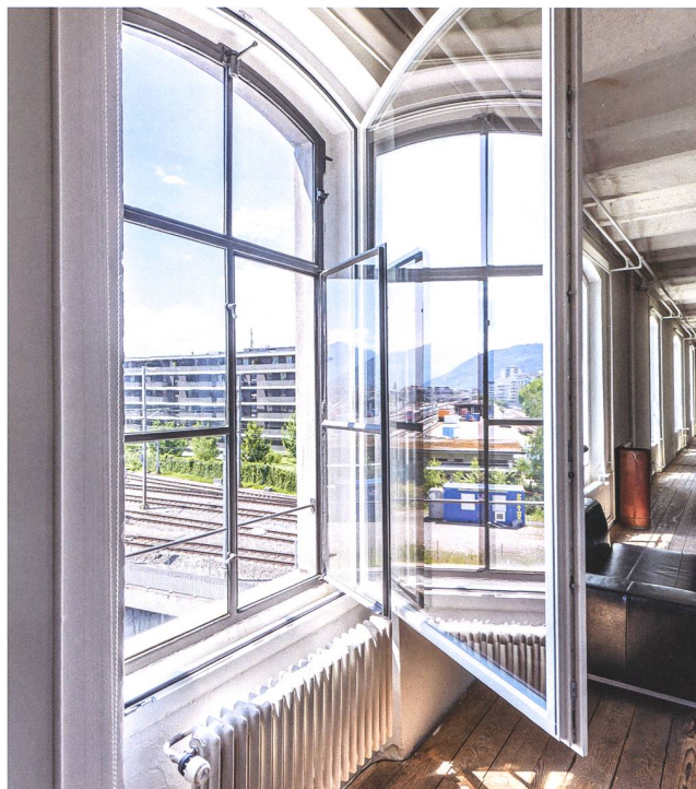
Abb. 4 Detail der Fensterertüchtigung: Das alte Gusseisenfenster wurde mit einem neuen, zusätzlichen Fensterflügel ergänzt.
