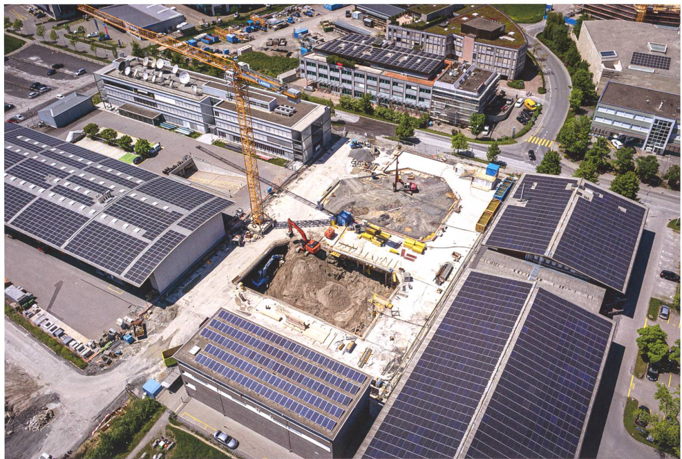
Abb. 18 Zug, Chollerstrasse 26. Bauperimeter kurz nach Aushubbeginn. Die Deckelplatte der Untergeschosse weist zwei grosse Öffnungen für die Aushubbagger auf. Blick nach Nordwesten in Richtung Autobahn. Oben rechts noch knapp angeschnitten das Gebäude Erlenweg 5 im Rohbau; die Sumpfstrasse 18 befindet sich rund 100 m weiter links. Der Aufnahmestandort des Bildes befindet sich fast direkt über dem Lauf der Alten Lorze.
