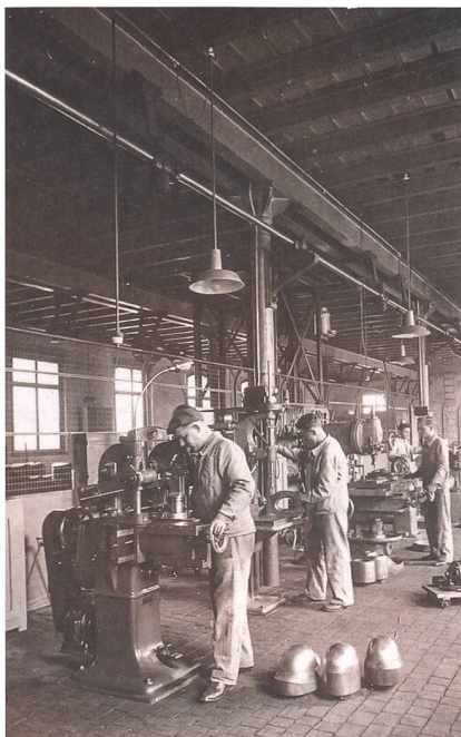
Abb. 8 Helmfabrikation in der Metallwarenfabrik Zug, 1930er Jahre. Anfang 1918 begann die Metallwarenfabrik mit der Serienproduktion des neuen Stahlhelms Ordonnanz 1918 der Schweizer Armee.
