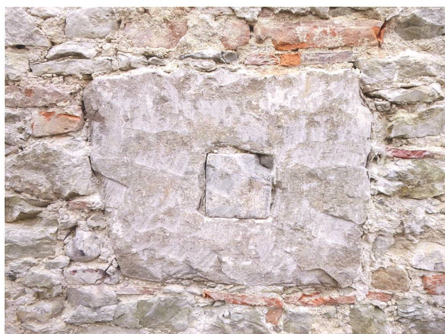
Abb. 9 Kloster Maria Opferung, Ostfassade des Gästehauses. Möglicherweise ist hier ein sogenanntes Sakrarium in Zweitverwendung (Spolie) als Bruchstein vermauert.
