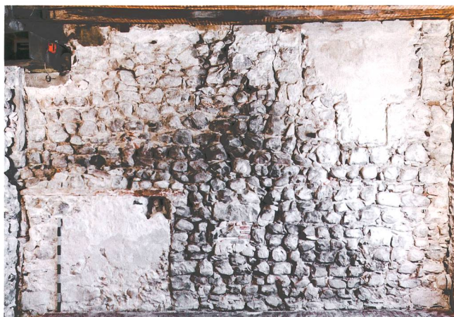
Abb. 15 Zug, Unteraltstadt 12. Westteil der Südmauer (Innenansicht), mit zugemauerter Tür und Sitznischenfenster. Blick nach Süden.
