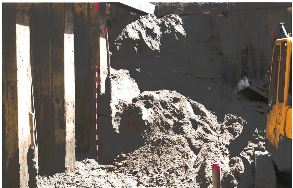
Abb. 35 Zug, Chamer Fussweg 17. Profilrest innerhalb der Spundwand. Die organisch gebänderten hellen und dunklen Deltaschüttungen zeichnen sich an der Aushubkante gut erkennbar ab.
