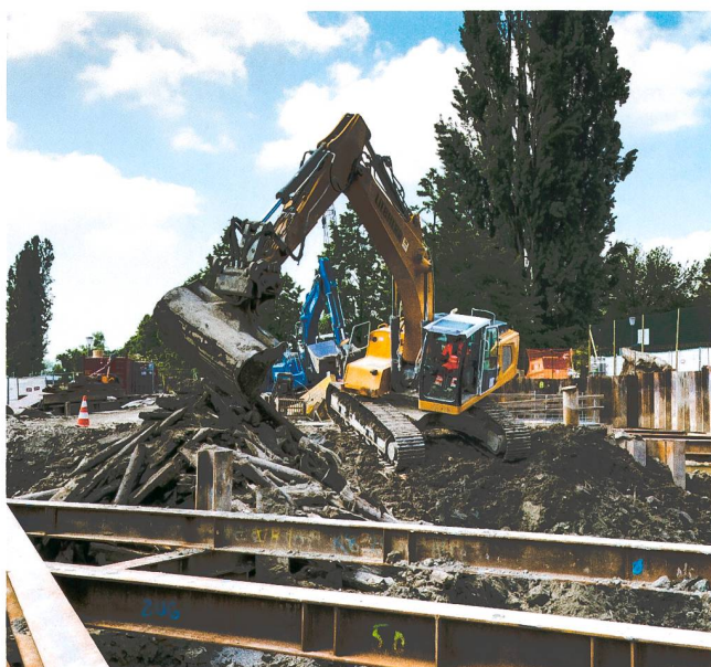
Abb. 47 Zug, Schützenmatt. Beim Aushub werden grosse Mengen von Hölzern – Balken wie Pfähle – ausgebaggert, die wohl zur Fundamentierung für die Sägereigebäude gehören.
