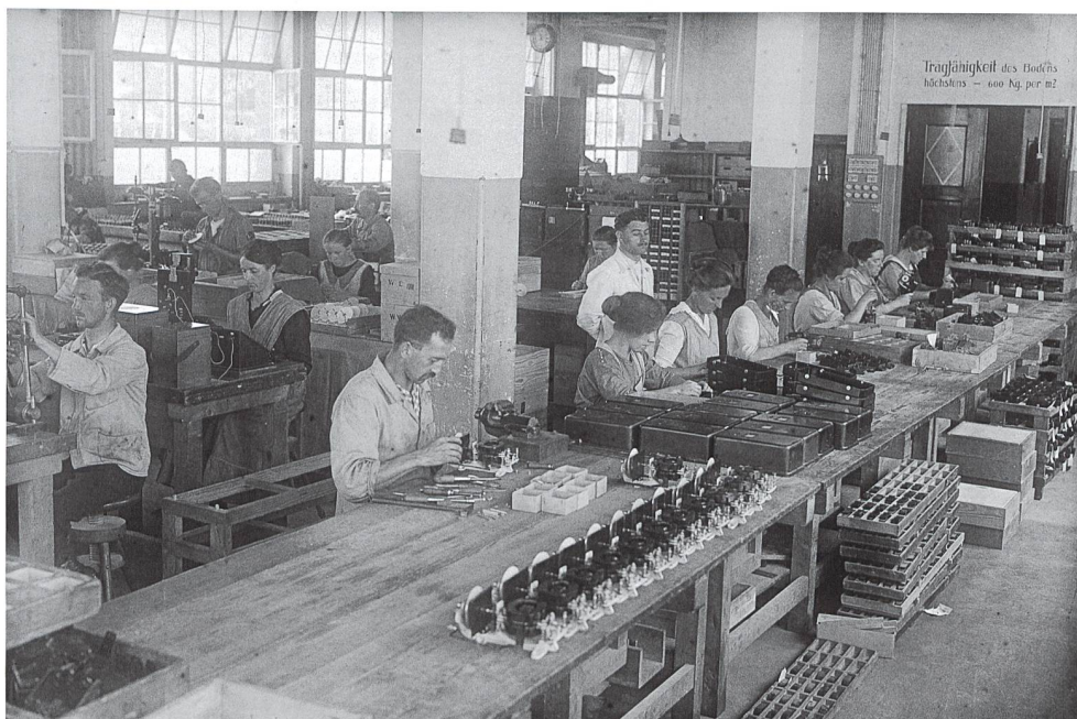
Abb. 5 Montage und Prüfung von Gleichstromzählern bei Landis & Gyr in Zug, ca. 1920.
