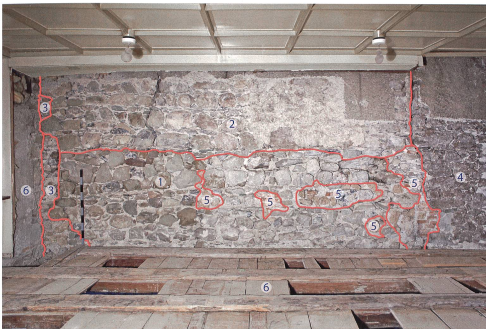
Abb. 4 Zug, Unteraltstadt 26, Nordmauer: 1 Mauerwerk des 13. oder frühen 14. Jahrhunderts. 2 Aufmauerung des nördlichen Nachbarhauses Unteraltstadt 24 um eine Geschosshöhe, vor dem Ufereinbruch von 1435. 3 Abbruchkante des Ufereinbruchs von 1435 und ihre Flickstellen. 4 Dreigeschossige Verbindungsmauer; zwischen 1435 und 1676d. 5 Jüngere Flickstellen. 6 Umbauphase und Erstellung Westfassade, 1852d. Blick nach Norden.
