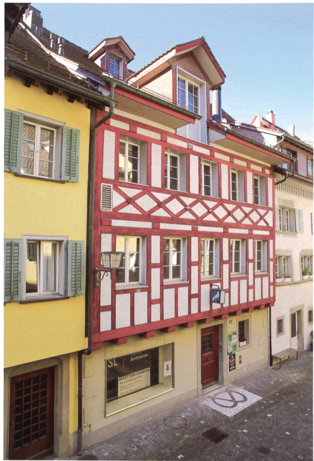
Abb. 1 Zug, Unteraltstadt 26. Fassade des ehemaligen Restaurants «Zur Taube», vor dem Umbau 2016–2018. Blick nach Nordwesten.
