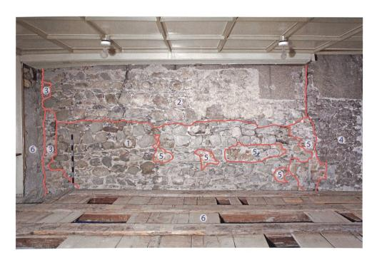
Abb. 4 Zug, Unteraltstadt 26, Nordmauer. 1 Mauerwerk des 13. oder frühen 14. Jahrhunderts. 2 Aufmauerung des nördlichen Nachbarhauses Unteraltstadt 24 um eine Geschosshöhe, vor dem Ufereinbruch von 1435. 3 Abbruchkante des Ufereinbruchs von 1435 und ihre Flickstellen. 4 Dreigeschossige Verbindungsmauer, zwischen 1435 und 1676d. 5 Jüngere Flickstellen. 6 Umbauphase und Erstellung Westfassade, 1852d. Blick nach Norden.
