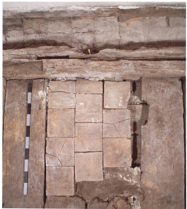
Abb. 7 Zug, Unteralstadt 26, erstes Obergeschoss, Boden von 1462d, Aufsicht. Fundament eines Kachelofens. Blick nach Westen.
