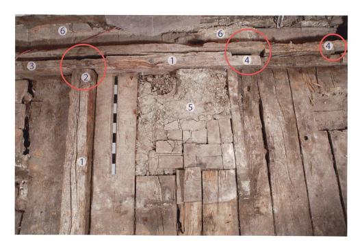
Abb. 6 Zug, Unteraltstadt 26, erstes Obergeschoss, Boden von 1462d, Aufsicht. 1 Schwellbalken. 2 Schwellenschloss und Fundort des Steinfüsschens. 3 Nut für Bohlenwand. 4 Zapflöcher für Türpfosten. 5 Fundament eines Kachelofens. 6 Negative eines Tonplattenbodens im ehemaligen Nebenraum (Küche). Blick nach Westen.
