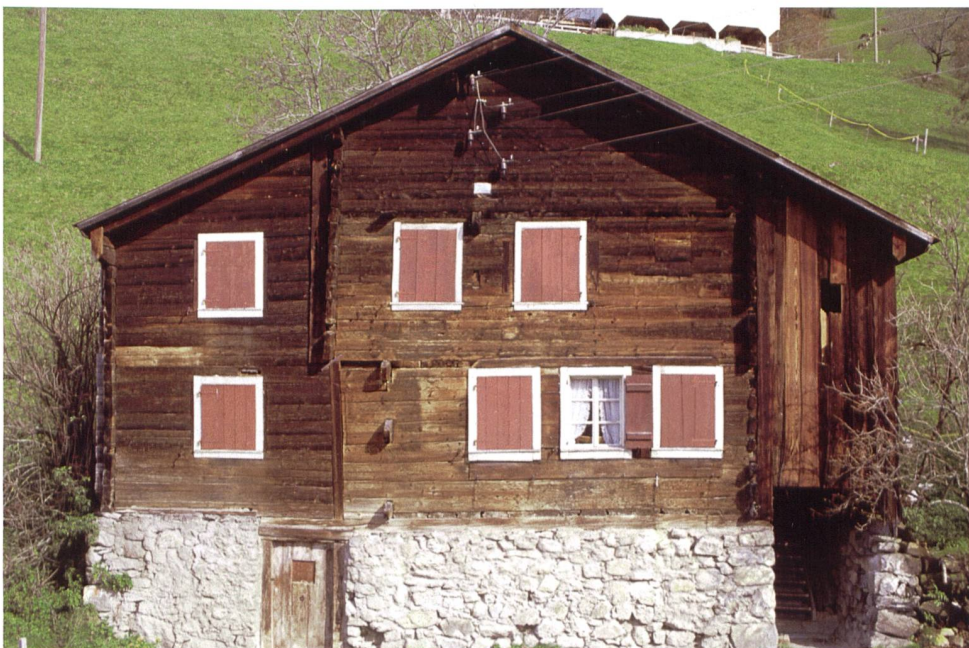
Abb. 12 Morschach, Tannen. Spätmittelalterliches Wohnhaus von 1342 mit fassadensichtigen Boden-/Deckenbohlen. Seit 2017 für «Ferien im Baudenkmal» genutzt. Aufnahme 1984.
