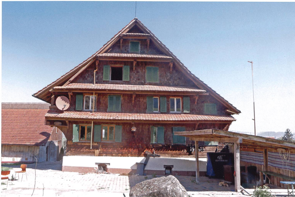
Abb. 18 Risch, Obere Bach-talen 2. Rückwärtige Giebel-fassade in Kantholzständer-bauweise.
