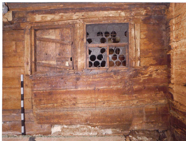
Abb. 13 Menzingen, Alte Landstrasse 8. Stubenwand mit bauzeitlichem Doppelfenster. Blick nach Nordosten.
