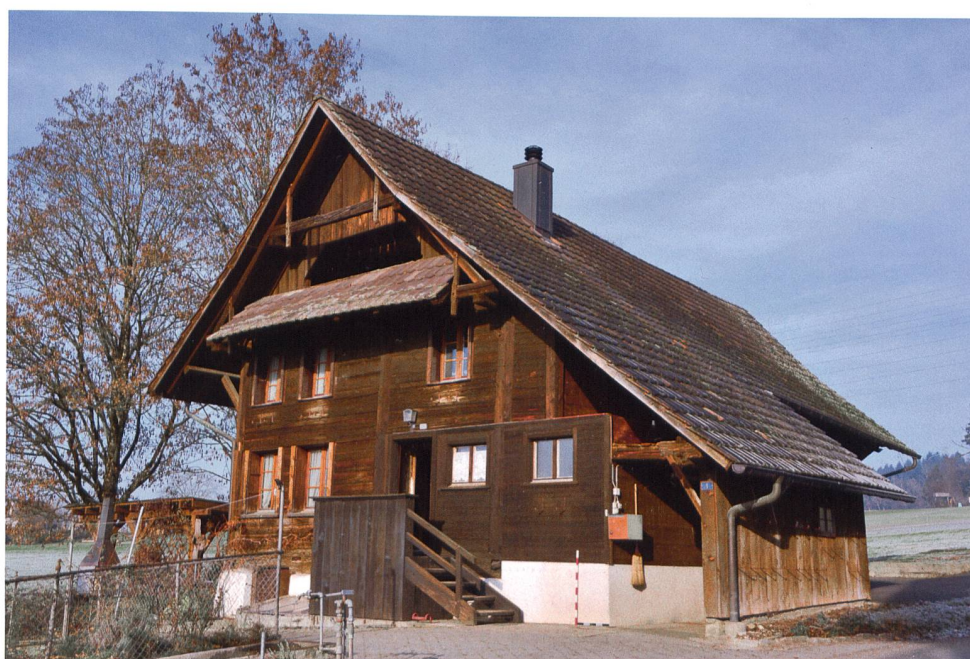
Abb. 23 Steinhausen, Wald 1. Ansicht des Vielzweckbaus von Südosten.
