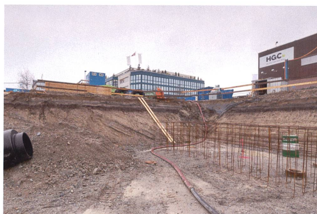
Abb. 2 Blick in die südwestliche Ecke der Baugrube mit der für die Parzelle typischen Stratigraphie, hinten der «Chollerpark». Gut erkennbar ist die Fundschicht, ein dunkelbrauner Torf. Dieser wird unterlagert von deutlich gegen den See hin schräggestellten, fein geschichteten grauen Sanden, die hier von der Lorze in ihrem alten Delta abgelagert worden sind.
