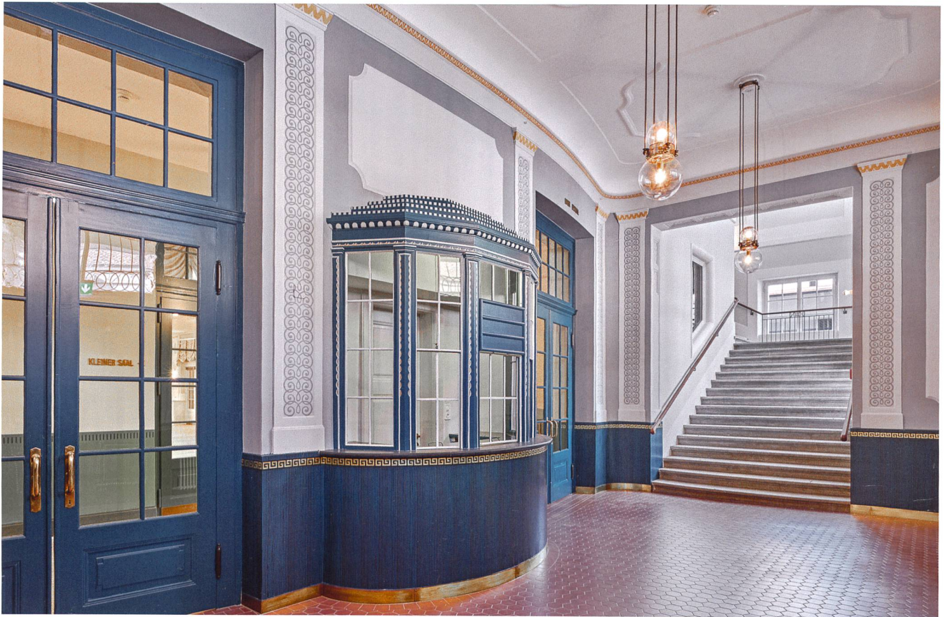
Abb. 26 Zug, Artherstrasse 4, Theater Casino. Historisches Kassenhäuschen beim Osteingang mit rekonstruierter bauzeitlicher Farbfassung.
