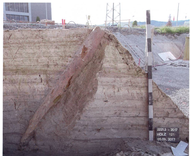
Abb. 21 Steinhausen, Sennweid. Der Pfahl im Arbeitsprofil stand ursprünglich aufrechter, durch den Druck der oberen Schichten wurde er umgedrückt, und die anstehenden Schichten links vom Pfahl wurden leicht gestaucht.
