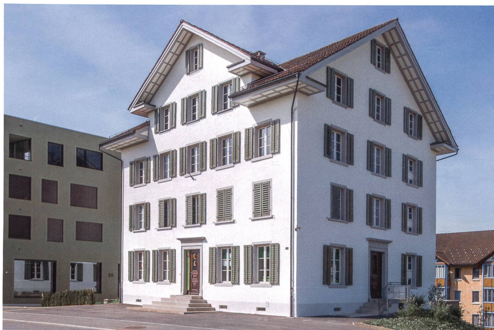
Abb. 24 Steinhausen, Zugerstrasse 12. Das ehemalige Bürgerheim von Steinhausen ist ein stattliches, spätklassizistisches Bauwerk aus der zweiten Hälfte des 19. Jahrhunderts und steht direkt an der Hauptstrasse Richtung Zug. Ansicht von Nordosten.
