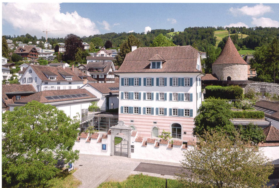
Abb. 30 Zug, Dorfstrasse 27, «Hof», Kunsthaus. Bei der aktuellen Aussensanierung wurde die stark verblasste Farbgebung von 1990, die Alt- und Neubauten nach dem einem Gesamtkonzept des Architekten Franz Füeg verbindet, wiederhergestellt.
