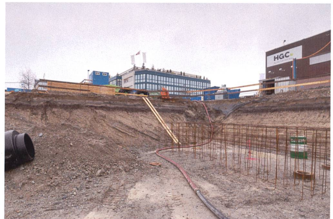
Abb. 2 Blick in die südwestliche Ecke der Baugrube mit der für die Parzelle typischen Stratigrafie, hinten der «Chollerpark». Gut erkennbar ist die Fundschicht, ein dunkelbrauner Torf. Dieser wird unterlagert von deutlich gegen den See hin schräggestellten, fein geschichteten grauen Sanden, die hier von der Lorze in ihrem alten Delta abgelagert worden sind.
