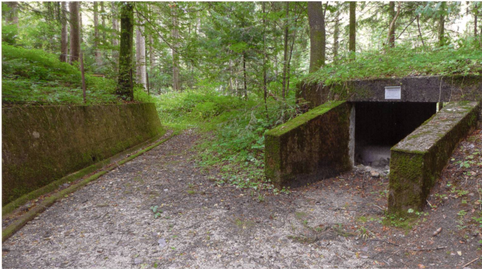
Abb. 8 Der Infanteriekanonen-Feuerschild im Sibrischboden westlich von Unterägeri ist ein offenes Werk, das im Waldboden eingetieft ist. Die Kanone war in der nahe gelegenen Infanteriekanonen-Garage eingestellt. Über den grosszügigen Vorbereich wurde die Kanone in den Feuerschild gebracht.
