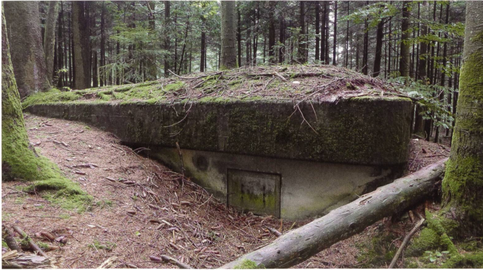
Abb. 5 Zum Ensemble um die Panzermauer in der Schurtannenweid gehören auch Unterstände, die zum grossen Teil ins Erdreich eingegraben sind. Diese Mannschaftsunterkünfte waren für zwölf Mann eingerichtet.
