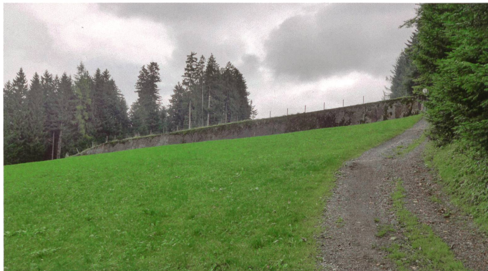
Abb. 2 Die Panzermauer in der Schurtannenweid (Gemeinde Menzingen) bildet zusammen mit den Panzergräben im Chnollen und auf der Fürschwand die Réduitlinie in diesem Gebiet sehr anschaulich ab.
