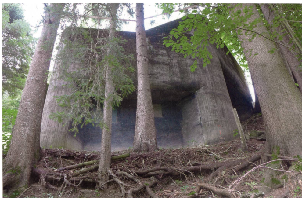
Abb. 1 Der Infanteriebunker «Philippensburg» nordwestlich von Unterägeri wurde 1942 fertiggestellt. Das Maschinengewehrwerk hat zwei Kampfräume mit je einer Beobachterscharte, die auf die Strasse von Neuägeri nach Unterägeri wirken konnten. Einzigartig ist der 25 m lange, unterirdische Stollen, der die Kampfräume mit einer grossen Unterkunft verbindet.
