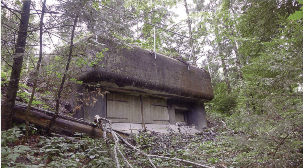
Abb. 3 Panzerabwehr-geschützstand im Sibrischboden westlich von Unterägeri. Der massive Bau ist Teil der Sperre an der Nebenstrasse von Neu-ägeri nach Unterägeri.
