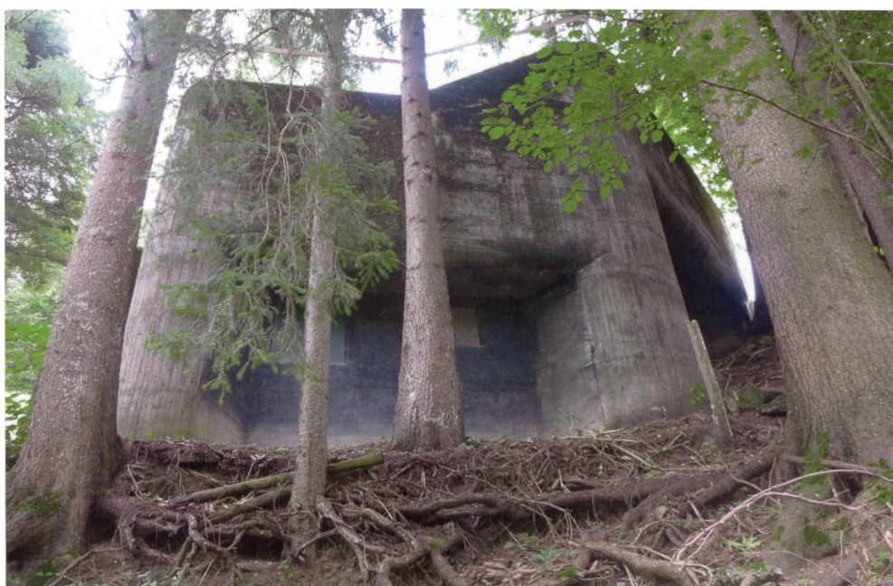
Abb. 1 Der Infanteriebunker «Philippsburg» nordwestlich von Unterägeri wurde 1942 fertiggestellt. Das Maschinengewehrwerk hat zwei Kampfräume mit je einer Beobachterscharte, die auf die Strasse von Neuägeri nach Unterägeri wirken konnten. Einzigartig ist der 25 m lange, unterirdische Stollen, der die Kampfräume mit einer grossen Unterkunft verbindet.
