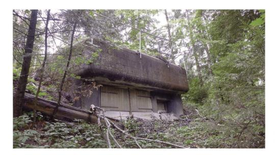
Abb. 3 Panzerabwehrgeschützstand im Sibrischboden westlich von Unterägeri. Der massive Bau ist Teil der Sperre an der Nebenstrasse von Neuägeri nach Unterägeri.
