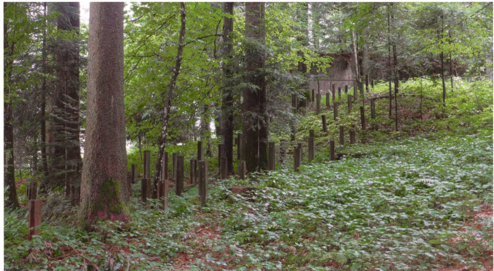
Abb. 4 Ein Anschlusshindernis aus einbetonierten Eisenbahnschienen verlängert im Wald die Panzermauer in der Schurtannenweid (Gemeinde Menzingen).
