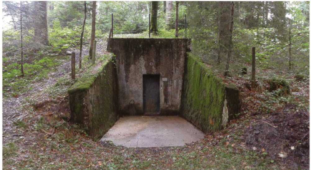
Abb. 6 Der Artillerie-Kommando-posten «Pandur» befindet sich im Banholz auf dem Zugerberg. Die Kaverne mit gewölbter Decke und abgewinkeltem Zugangsstollen liegt gänzlich unter Terrain. Aussen sichtbar ist nur der Eingang, der mit seiner symmetrischen Gestaltung monumental überhöht wirkt.
