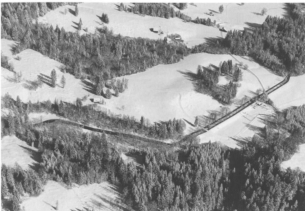
Abb. 1 Das längste militärische Bauwerk im Kanton Zug: das über 500 m lange Panzerhindernis im Sibrischboden westlich von Unterägeri, bestehend aus einem Panzergraben (rechts) und einer Panzermauer (links). Aufnahme vom 28. März 1995.
