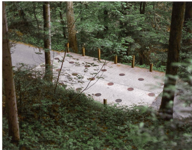
Abb. 6 Panzerbarrikade Zigerhüttli südöstlich von Alosen (Gemeinde Oberägeri) mit seitlich einbetonierten Eisenbahnschienen und gusseisernen Deckeln über den Schächten zur Aufnahme der gleichen Einsteckelemente.
