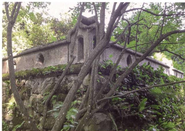
Abb. 11 Vom «Neuen Schloss» blieben nach dem Abbruch nur die Terrasse und Teile von deren neugotischer Brüstung erhalten. Aufnahme von 2016.
