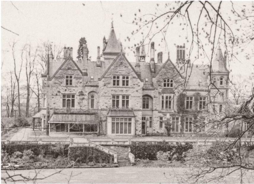
Abb. 8 Buonas, «Neues Schloss». Ansicht von Süden, 1970. Der vom britischen Architekten William Wilkinson 1873–1877 im Stil der Neugotik errichtete Landsitz wurde 1970 abgebrochen.
