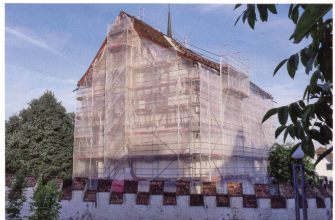
Abb. 6 Die verhüllte Burg während der Fassadensanierung.
