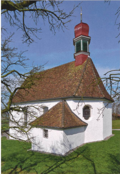
Abb. 22 Hünenberg, Weinreben, Weinrebenkapelle. Ansicht von Südosten.
