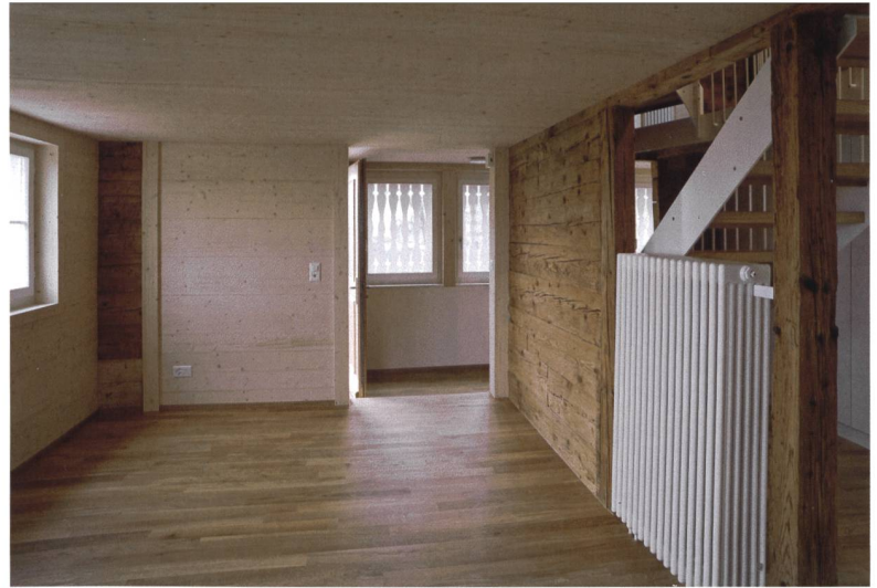
Abb. 4 Innenräume im ersten Obergeschoss, nach der Sanierung.
