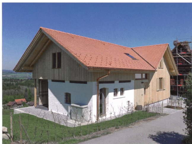
Abb. 21 Hünenberg, St. Wolfgang, ehemaliges Ökonomiegebäude. Ansicht von Südosten.
