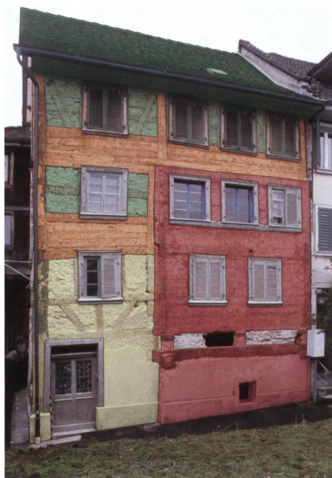
Abb. 1 Zug, Ägeristrasse 32. Nach Westen gerichtete Hauptfassade mit Bauphasen.
