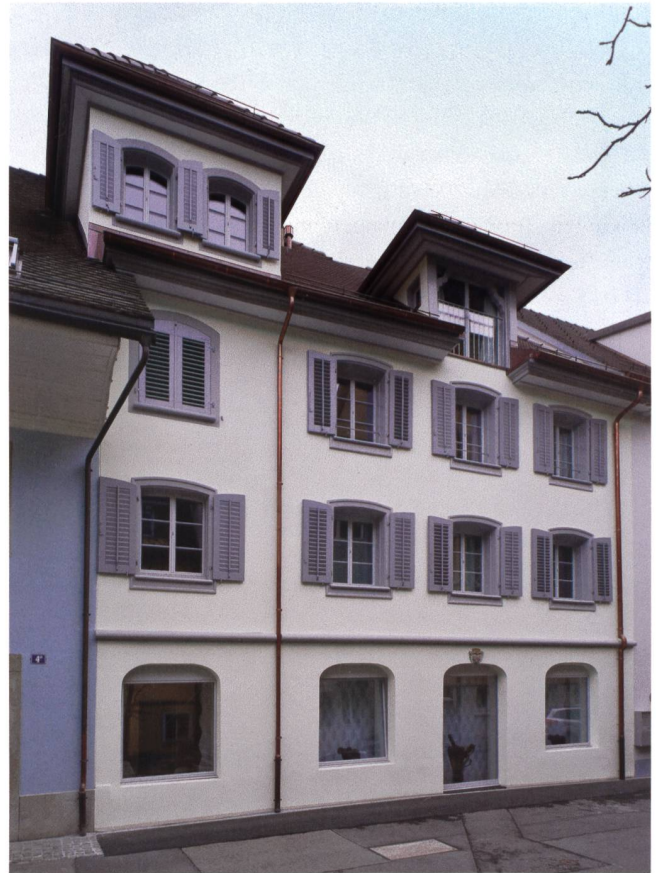
Abb. 39 Zug, St.-Antons-Gasse 5. Fassade des sanierten Altbaus. Ansicht von Norden.
