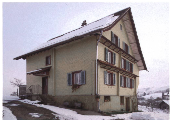
Abb. 7 Baar, Allenwinden, Spitzibüel 2. West- und Südfassade. Das 2016 abgebrochene Haus bestand im Süden aus einem Blockbau von 1607 oder kurz danach und im Norden aus einem Neubau von 1954.
