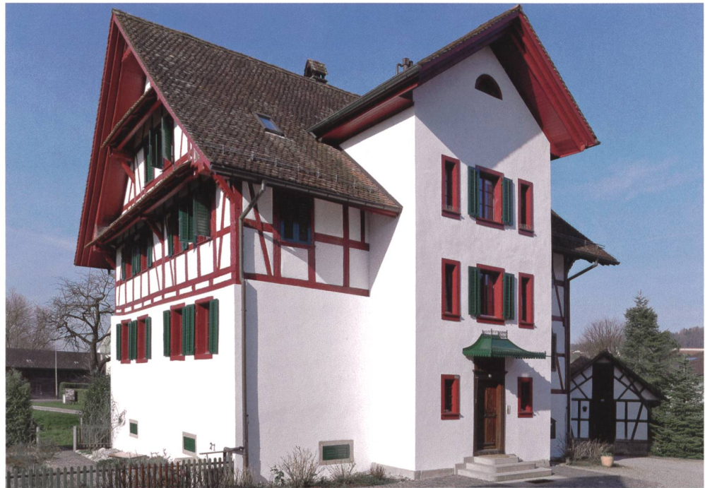
Abb. 6 Baar, Neugasse 40. Wohnhaus. Ansicht von Südosten.
