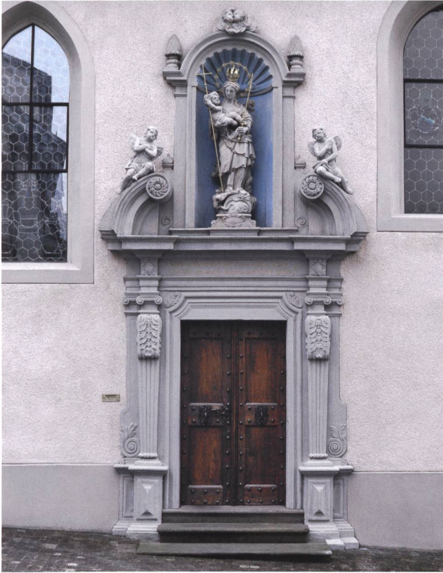
Abb. 41 Zug, Unteraltstadt, Liebfrauenkapelle. Nördliches Aussenportal nach der Reinigung. Ansicht von Norden.
