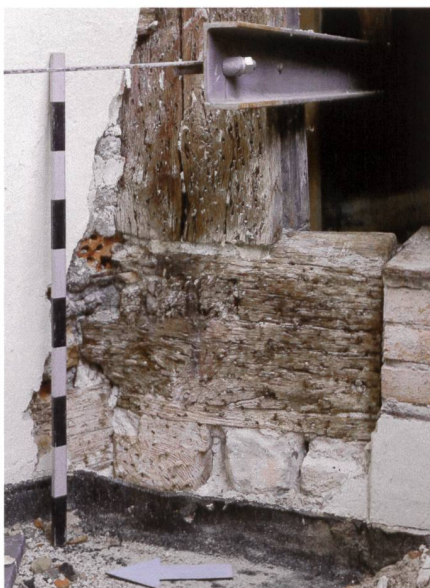
Abb. 36 Zug, Kolinplatz 21. Schwellenverbindung und Ständer an der Nordwestecke des ehemaligen Ständerbohlenbaus. Erkennbar ist der rote Anstrich. Blick nach Osten.
