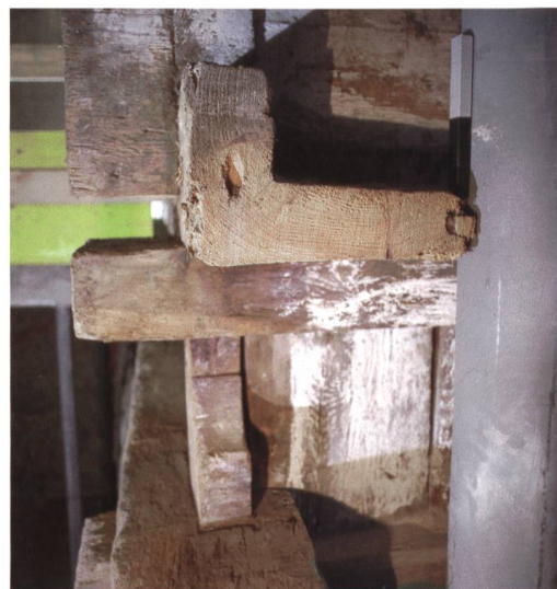
Abb. 2 Ungewöhnlicher «Winkelbalken» bei der Ostfassade, dient zugleich als Schwelle für den Blockbau als auch als östlichste Bodenbohle.
