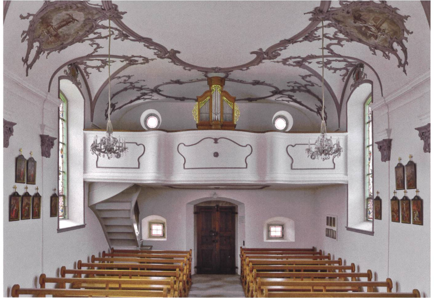
Abb. 23 Hünenberg, Weinreben, Weinrebenkapelle. Innenraum mit gereinigten und retuschierten Stuckaturen. Ansicht von Westen.
