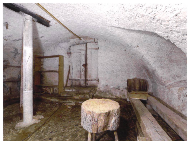
Abb. 9 Baar, Talacher 3. Tonnengewölbter Keller im hangseitigen Teil des Sockelgeschosses. Blick nach Westen.
