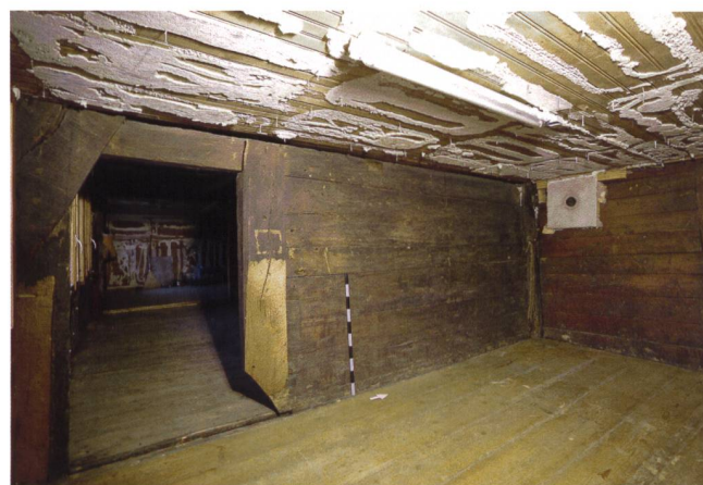
Abb. 20 Hünenberg, Dorfstrasse 2. Reste der Bohlenständerkonstruktion aus der Zeit um 1472/73. Die Türöffnung mit Mantelständer stammt aus einem späteren Umbau.
