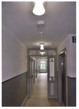
Abb. 3 Korridorzone im zweiten Obergeschoss, mit neuem Brandabschluss
