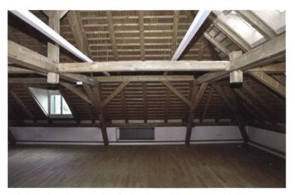
Abb. 4 Dachgeschoss mit originaler Dachkonstruktion und Schindelschirm.
