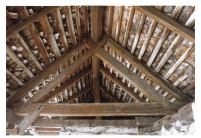
Abb. 3 Blick in die 1642/43 errichtete Dachkonstruktion über dem Wehrgang der Ringmauer.
