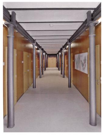
Abb. 25 **Risch, Buonas, ehemalige Stallscheune.** Innenansicht nach dem Umbau mit der Konstruktion von Hourdisdecken auf kunstvollen Gusseisensäulen.
