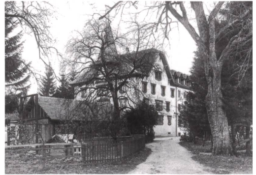
Abb. 2 Ansicht von Südosten, um 1900.
