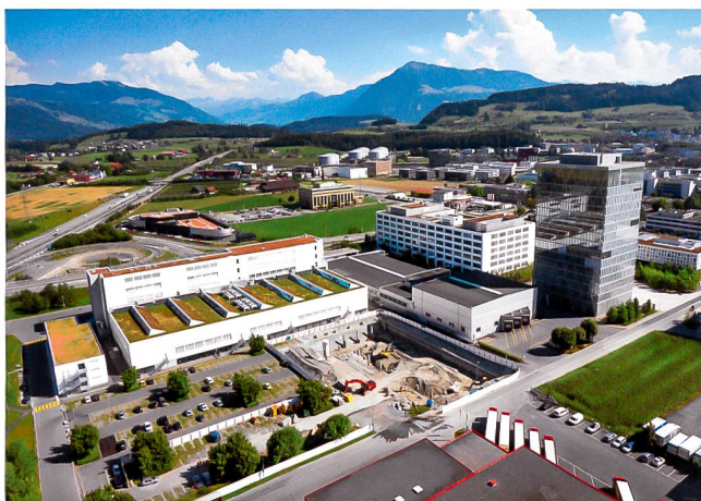
Abb. 1 Luftbild der Baugrube mit den umgebenden Gebäuden des Roche-Areals, Blick gegen Südosten auf Rossberg und Rigi. Die Fundorte der Mammutknochen liegen im hinteren Bereich der Baugrube.
