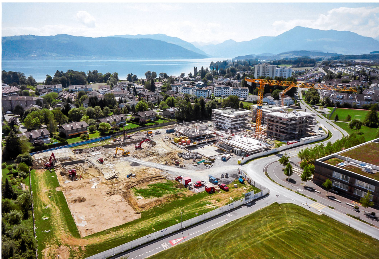
Abb. 11 Cham, Eichmatt II. Überblick über den Bauperimeter aus der Luft. Blick gegen Südosten, am rechten Bildrand angeschnitten das Schulhaus Eichmatt. Vorne links die Aushubarbeiten der zweiten Bauetappe, dahinter gruppiert um den Kran die Gebäude der ersten Etappe im Bau. Das spätere, in Abb. 13 gezeigte Stichprofil befindet sich zwischen den beiden roten Baggern am linken Rand der Baugrube.
