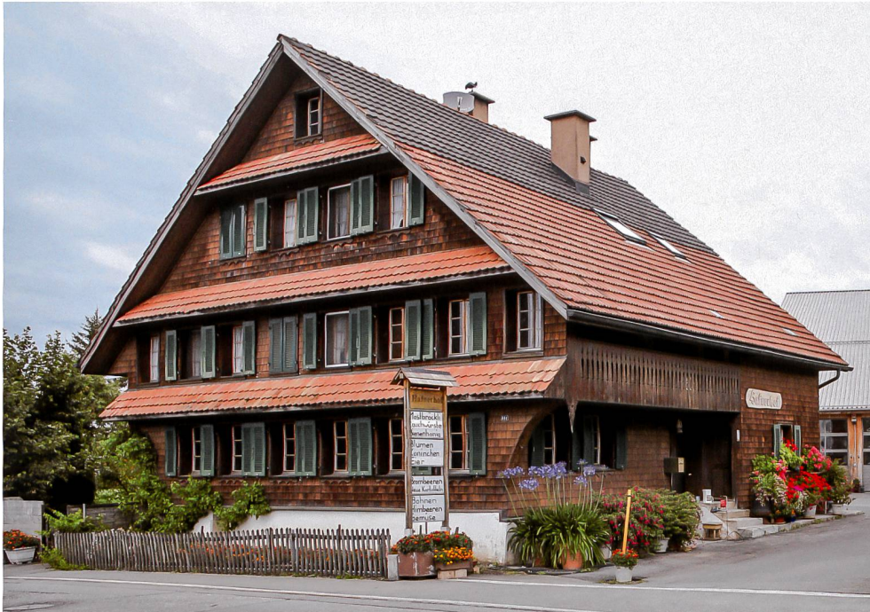
Abb. 18 Neuheim, Hafnerhof 1. Strassenseitige Hauptfassade. Blick nach Norden.
