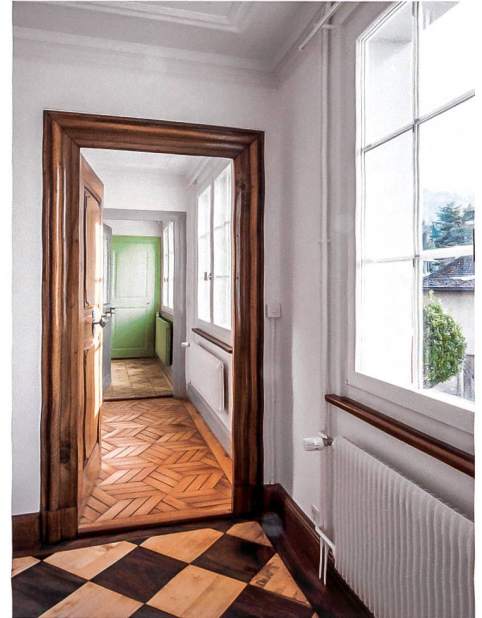
Abb. 2 Enfilade in der Wohnung Ost im ersten Obergeschoss, nach der Sanierung.
