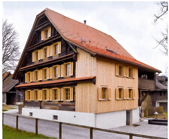
Abb. 2 Ansicht von Nordwesten, nach der Sanierung.
