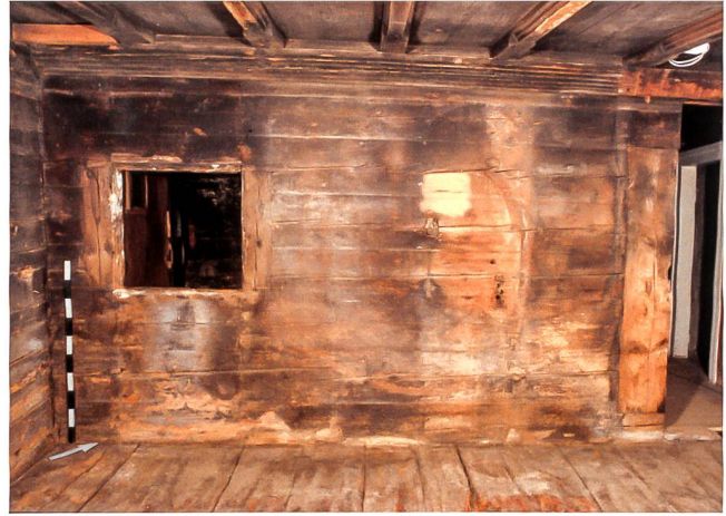
Abb. 2 Unterägeri, Haus Unterblacki. Blockbau aus dem 16. Jahrhundert. Westwand der Stube mit Bohlen-Bälkchen-Decke, Wand-schrank («Pestfenster») links und Stubentüre mit Mantelstud rechts. Das Gebäude ist für die Erforschung der Konstruktions- und Lebensweise des 16. Jahrhunderts und der darauffolgenden Zeit von sehr hohem Wert.
