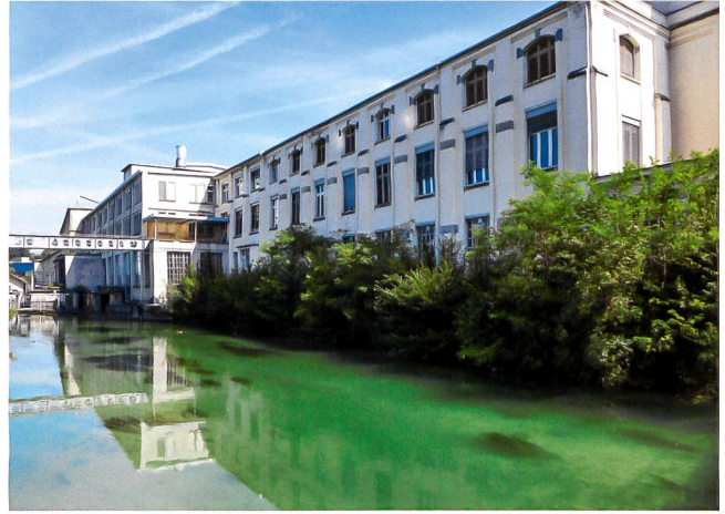
Abb. 5 Cham, Kalanderbau und Zwischentrakt der Papierfabrik, 1910 durch Séquin & Knobel, Rüti, bzw. 1924 durch Locher & Cie. erstellt. Zeuge für die Industriegeschichte. Die Papierfabrik hat über 350 Jahre die Entwicklung von Cham geprägt.
