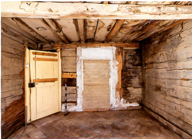
Abb. 2 Blick in die nordwestliche Eckkammer im ersten Vollgeschoss mit Bohlenbalkendecke.
