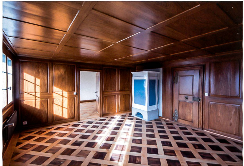
Abb. 4 Reich maserierter Raum in der Wohnung Ost im zweiten Obergeschoss, nach der Sanierung.
