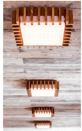
Abb. 2 Decke mit den sanierten Beleuchtungskörpern.
