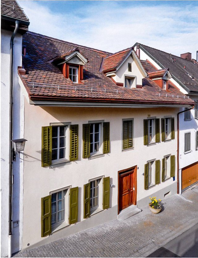
Abb. 43 Zug, Schanz 8. Blick von der Schanz an die Nordfassade.
