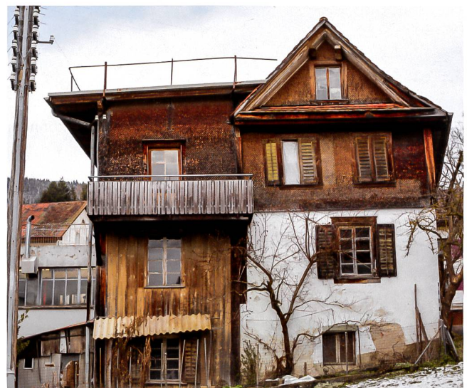
Abb. 21 Oberägeri, Mitteldorfstrasse 31. Südfassade mit der gut erkennbaren, westseitigen Hauserweiterung aus der Zeit um 1900.
