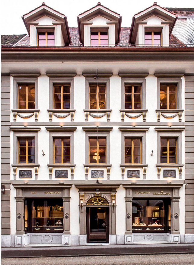
Abb. 40 Zug, Neugasse 27. Westfassade.
