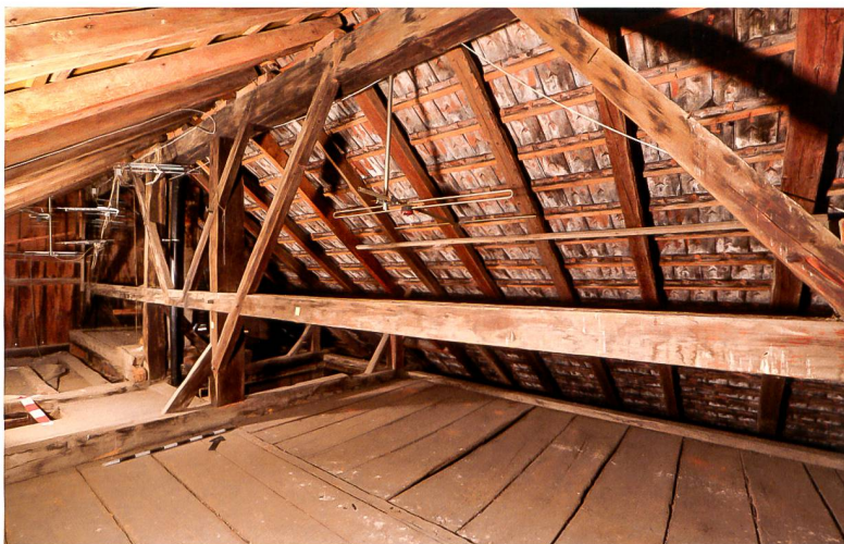
Abb. 3 Dachstuhl mit Firstsäulenreihe, Firstpfette und Streben.
