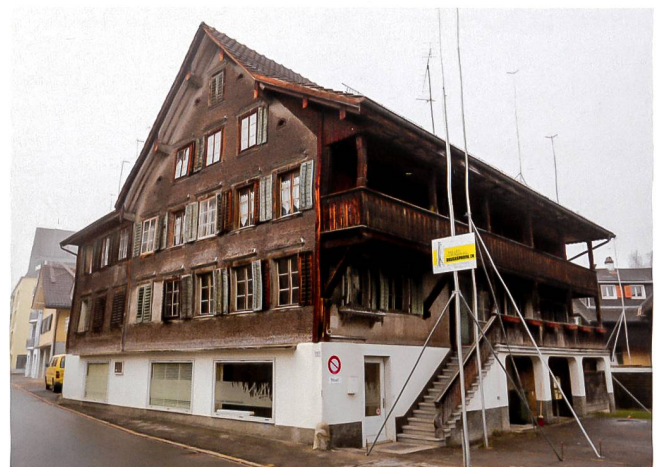
Abb. 31 Unterägeri, Lindengasse 2. Zur Lindengasse hin gerichtete Hauptfassade und Südseite mit den Lauben der 1920/30er Jahre. Blick nach Nordwesten.
