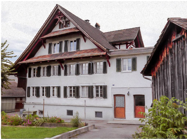
Abb. 2 Baar, Langgasse 47a. Hauptfassade mit aufwendigem Giebelschmuck. Blick nach Norden.
