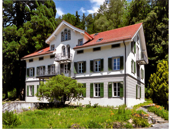
Abb. 5 Villa, Ansicht von Südwesten, nach der Sanierung.
