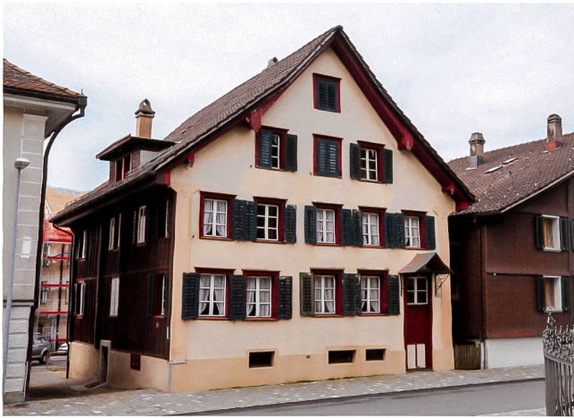
Abb. 30 Unterägeri, Alte Landstrasse 75. Verputzte Strassenfassade des Blockbaus im Dorfverband. Blick nach Süden.
