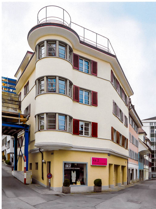
Abb. 42 Zug, Schanz 2, Wohn- und Geschäftshaus. Ansicht von Nordwesten.
