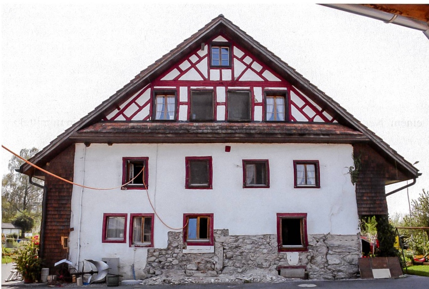
Abb. 19 Neuheim, Hafnerhof 1. Rückfassade. Hinterhaus mit teilweise freigelegter Mauer. Blick nach Südwesten.
