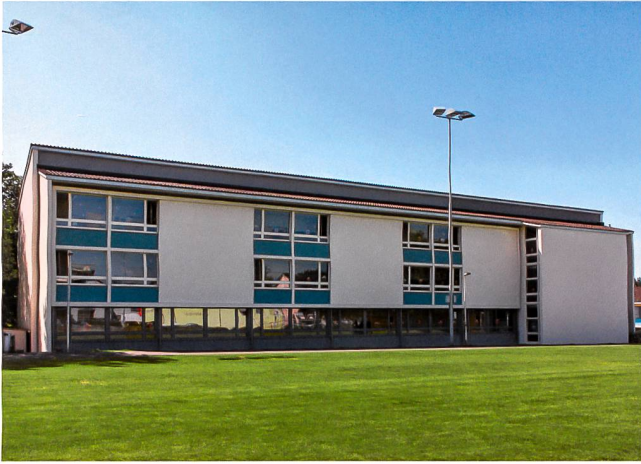
Abb. 4 Baar, Schulhaus Sternmatt, 1957 von Leo Hafner und Alfons Wiederkehr erbaut. Das Schulhaus entspricht hinsichtlich Bautypologie den pädagogischen Vorstellungen der 1950er Jahre: Pavillonbauweise, nach Funktionen getrennte, locker miteinander verbundene Einzelbauten, zweiseitig belichtete Klassenräume über Oberlichtband durch asymmetrisch aufeinander stossende Dachflächen.
