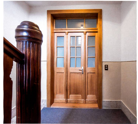
Abb. 2 Treppenhaus mit maseriertem Wohnungsabschluss, nach der Sanierung.
