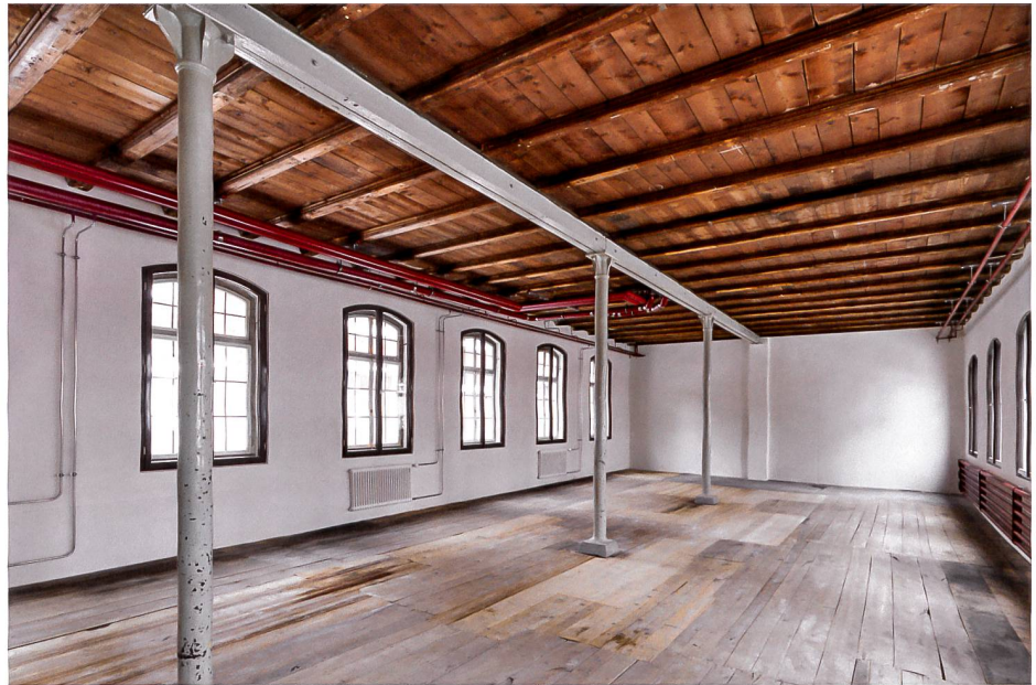
Abb. 4 Ehemaliger Gewerberaum im Erdgeschoss. Bauzeitliche Stützen und freigelegte Holzdecke, nach der Sanierung.
