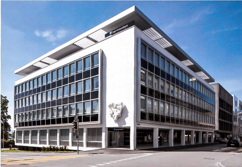
Abb. 3 Hauptgebäude der Zuger Kantonalbank, 2016, nach der Sanierung.
