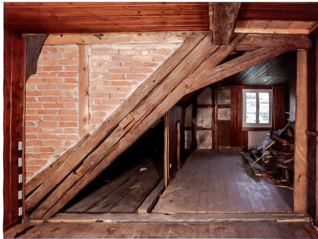
Abb. 3 Baar, Langgasse 47a. Südliches Joch des liegenden Dachstuhls. Blick nach Süden.
