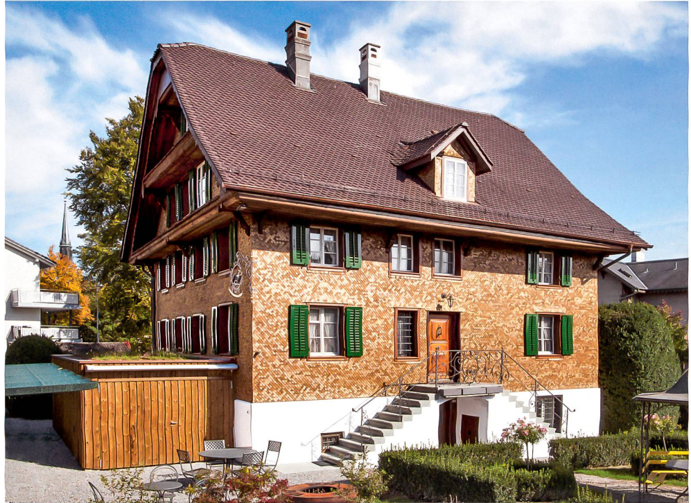
Abb. 15 Cham, Luzernerstrasse 40, Alter Raben. Ansicht von Westen.
