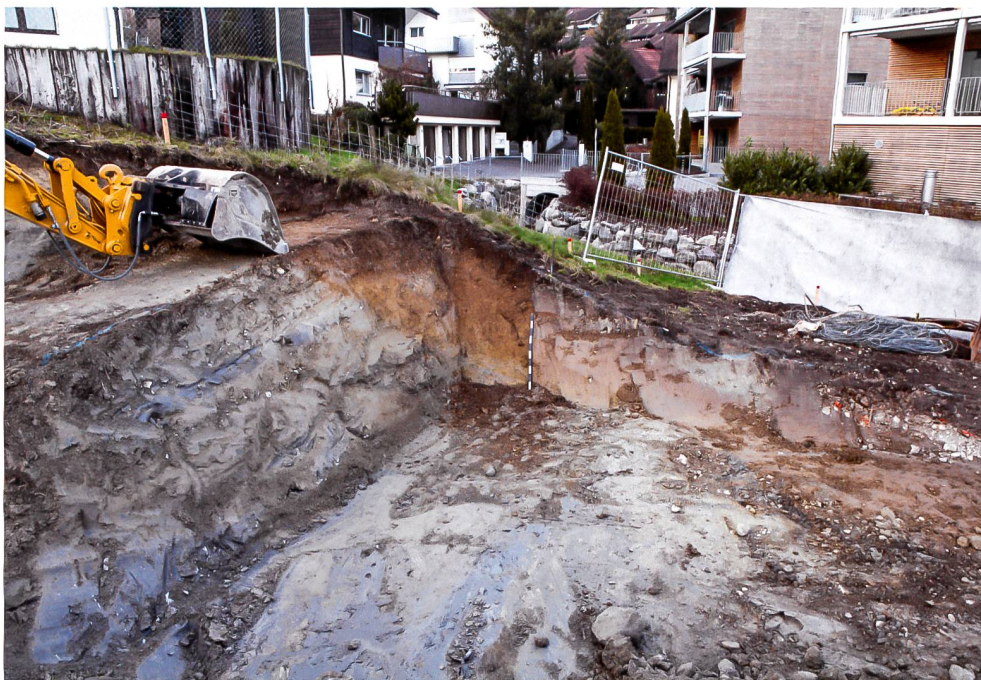
Abb. 5 Baar, Blickensdorf, Steinhauserstrasse 4. Baustellenübersicht während des Aushubs der Baugrube. Mit steil abfallendem Felsen und Bodenaufbau.
