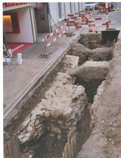
Abb. 54 Zug, Zeughausgasse, Strassensanierung. Im Vordergrund die freigelegte Stadtmauer. Sie war im Fundament gut 2,3 m und im ehemals aufgehenden Bestand knapp 2 m mächtig. Blick nach Norden.
