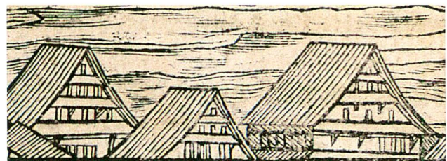
Abb. 6 Häuser von Oberägeri mit Schutzdächern oberhalb der Fensteröffnungen. Detail aus dem Holzschnitt «Die Schlacht am Morgarten» in der Schweizer Chronik von Johannes Stumpf, 1547.
