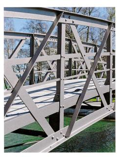
Abb. 53 Unterägeri, Birkenwäldli, Bogenbrücke Lorze. Detail der genieteten Stahlkonstruktion.
