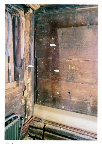
Baar, Altgasse 5. Bohlenständerbau von 1555. Stube im Erdgeschoss. Links: Stubenfenster und südöstlicher Eckständer von innen. Zu beachten ist der Rillenfries, der den Fensterwagen am Fensterpfosten und am Geschossriegel begleitet.
