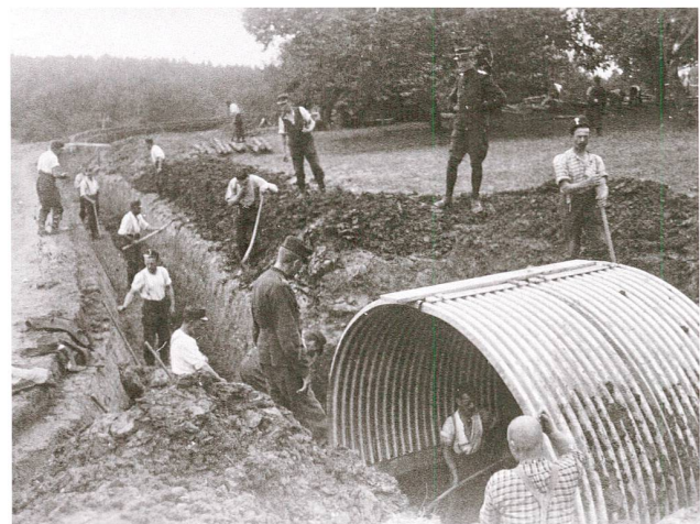
Abb. 9 Bau von Feldbefestigungen durch die Füsilierkompanie 1/48 im Bruderholz (26. August 1914). Um der Mannschaft einen besseren Schutz gegen Artilleriebeschuss zu bieten, werden Wellblechunterstände eingebaut und mit Erde überdeckt.
