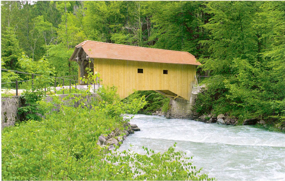
Abb. 13 Baar/Menzingen, Lorzentobelbrücke. Holzbrücke von 1758/59 nach der Sanierung 2012. Ansicht von Norden.
