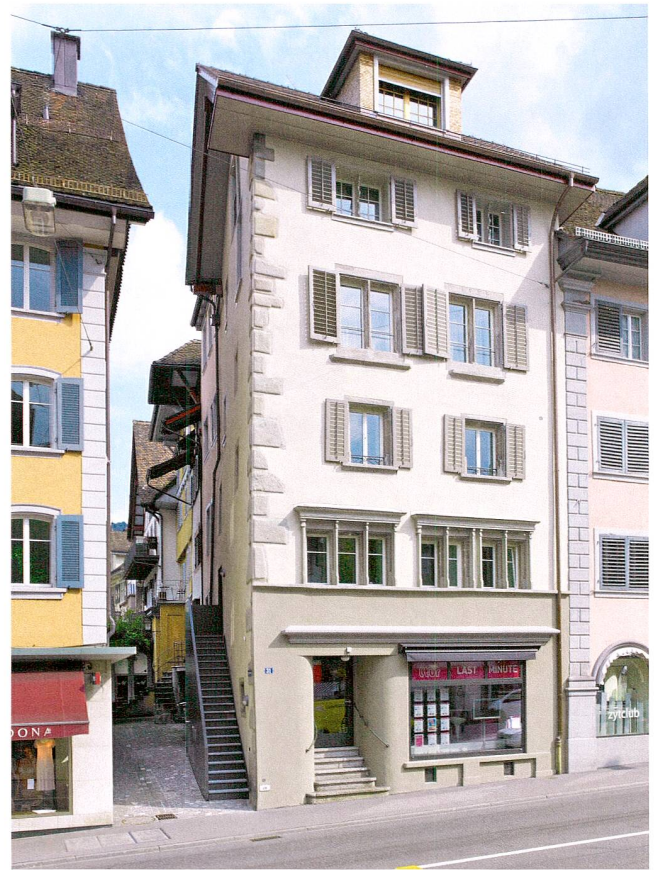
Abb. 58 Zug, Neugasse 31, Wohnhaus. Ansicht von Westen.
