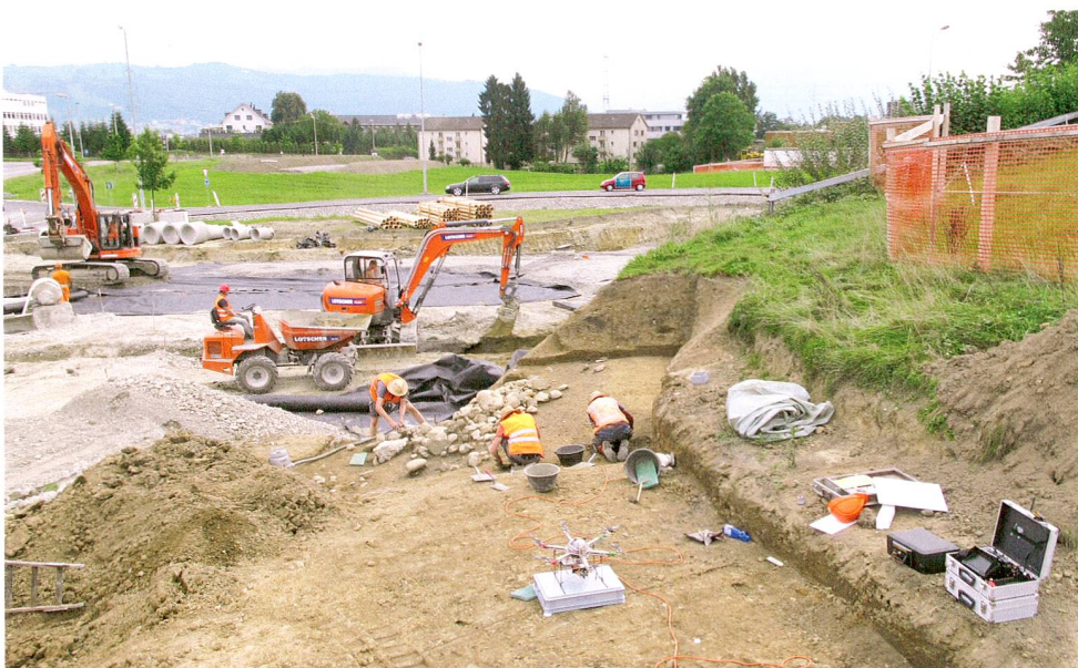
Abb. 16 Cham, Grindel–Bibersee, Ausbau Verkehrsknoten. Freilegung einer prähistorischen Scherbenführenden Steinpackung am Osthang des Grindel. Im Hintergrund Baggerarbeiten im Bereich des neuen Verkehrskreisels. Blick nach Südosten.
