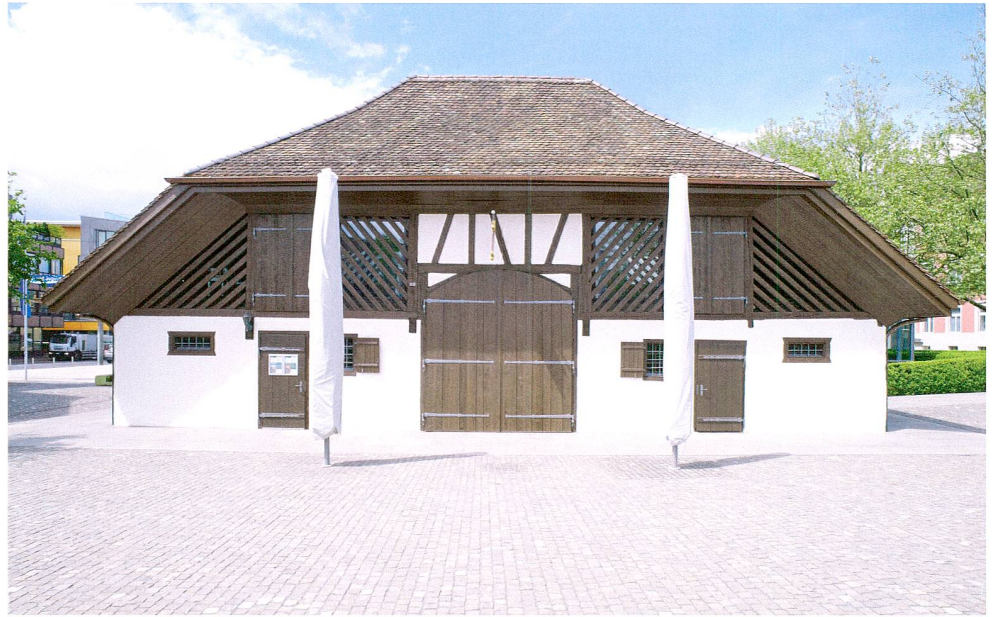
Abb. 12 Baar, Rathausstrasse 2, Rathaus- scheune. Ansicht von Süden.
