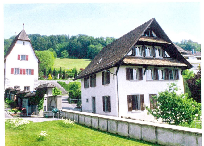
Abb. 64 Zug, Schwertstrasse 6, Wohnhaus, Ansicht von Westen. Im Hintergrund links das 1920 errichtete neugotische Dienstgebäude des Friedhofs St. Michael («Dagobertkapelle»).
