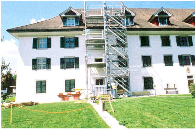
Abb. 14 Cham, Kloster Frauental. Ostflügel, Ostfassade. Einbau der Liftanlage am Übergang vom Ost- zum Südflügel.
