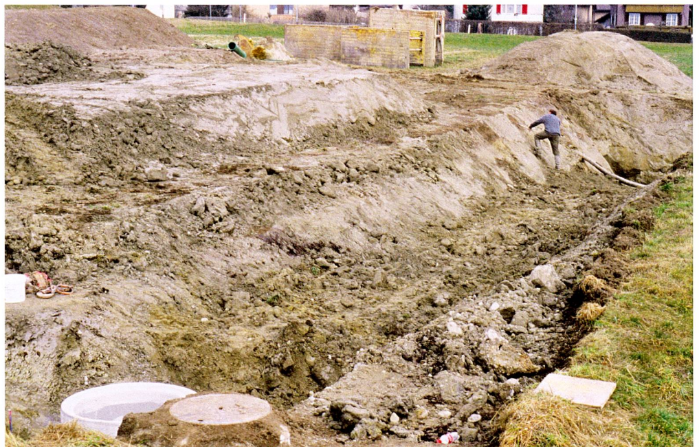
Abb. 33 Steinhausen, Unterfeldstrasse. Schwierige Spurensuche im Leitungsgraben. Blick Richtung Nordosten.
