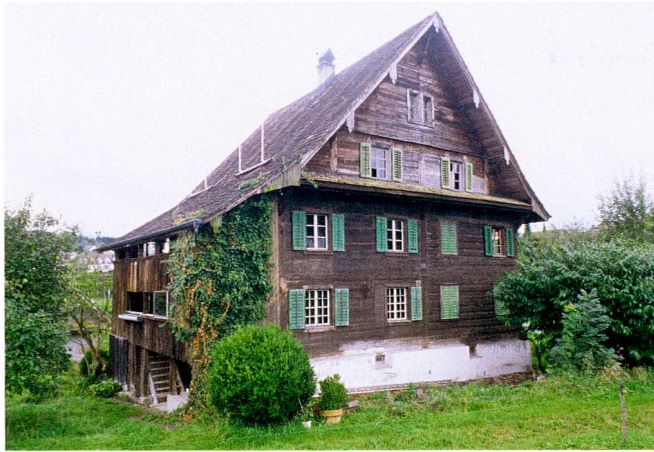
Abb. 29 Risch, Buonas, Dersbachstrasse 4, Wohnhaus. Rückseite des 1539 errichteten Ständerbaus. Ansicht von Nordosten.
