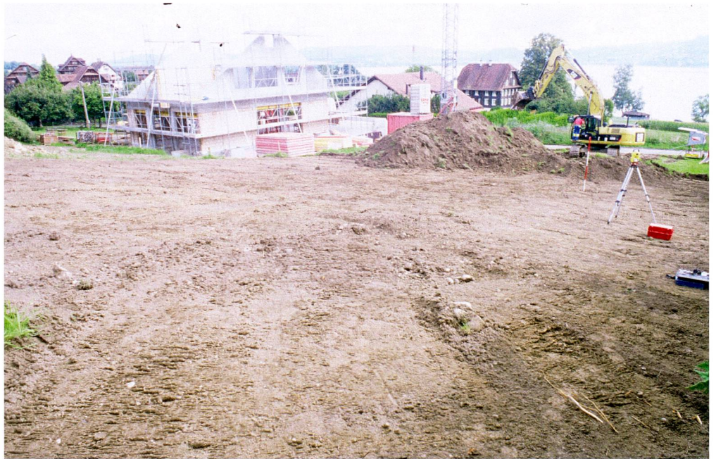
Abb. 32 Risch, Buonas, Seeblickweg 6. Baustellenübersicht mit abhumusierter Fläche. Der Jalon rechts hinten bezeichnet die Fundstelle der römischer Ziegelfragmente.
