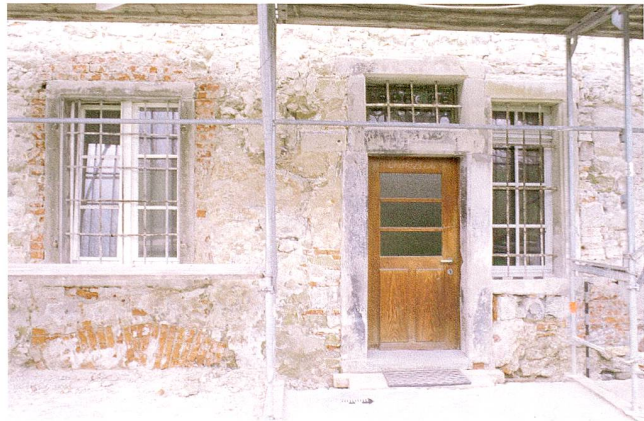
Abb. 15 Cham, Kloster Frauental. Ostflügel, Ostfassade. Untersuchung der Fassaden im März 1997. Unter dem Fenster links der Backsteinboden für die ehemalige Abortanlage.
