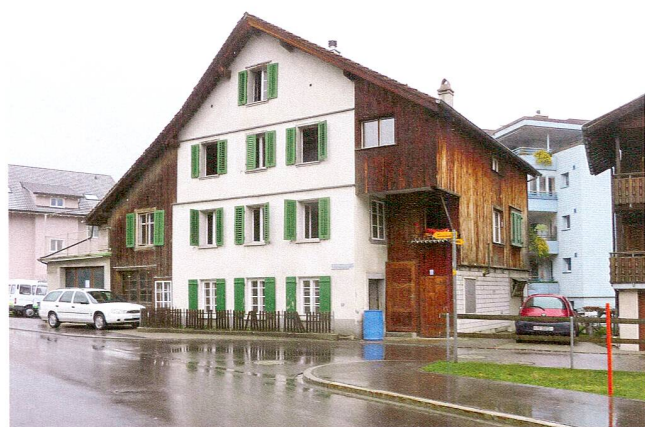
Abb. 36 Unterägeri, Binzenstrasse 10, Wohnhaus. Das 2011 abgebrochene Wohnhaus. Den Kern bildete ein zweigeschossig gemauerter Sockel mit einem zugehörigen, in Fachwerk errichteten zweiten Obergeschoss und dem stehenden Dachstuhl. Über der Türe ins Erdgeschoss stand die Jahreszahl 1841. Ansicht von Osten.
