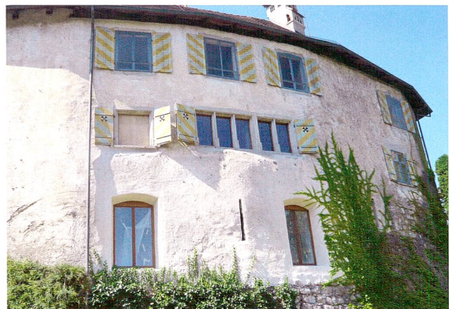
Abb. 21 Cham, St. Andreas I, Schloss St. Andreas. Ostfassade mit dem zum Teil sichtbaren Mauerwerk der ursprünglichen Mantelmauer; vor bzw. nach den Baumassnahmen von 2010/11. Auf das Ausbrechen einer ursprünglich geplanten grossen Fensteröffnung zwischen den beiden bestehenden Fenstern wurde nach der archäologischen Untersuchung verzichtet.
