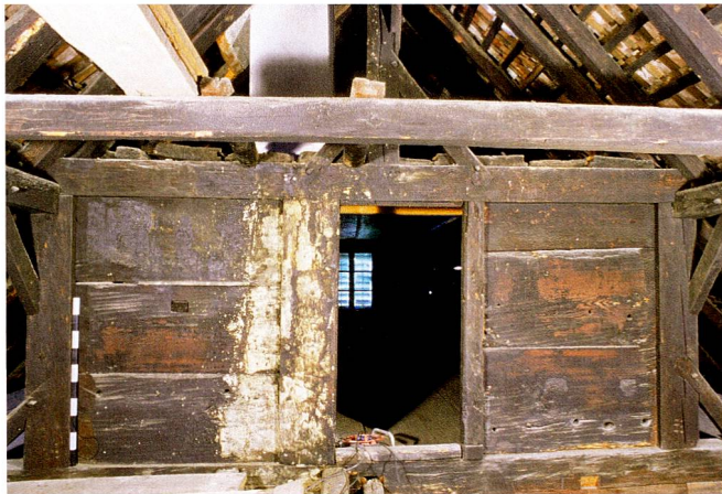
Abb. 31 Risch, Buonas, Dersbachstrasse 4, Wohnhaus. Firstkammer im zweigeschossigen, stehenden Dachstuhl von 1652, Blick nach Süden.
