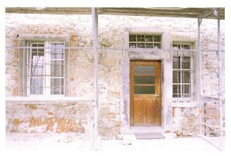
Abb. 15 **Cham, Kloster Frauental.** Ostflügel. Ostfassade. Untersuchung der Fassaden im März 1997. Unter dem Fenster links der Backsteinboden für die ehemalige Abortanlage.
