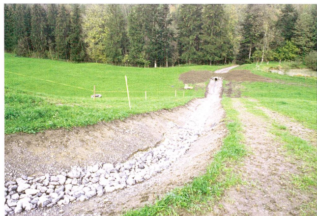
Abb. 27 Menzingen, Bostadel. Bachbett nach vollendeter Ausdolung.
