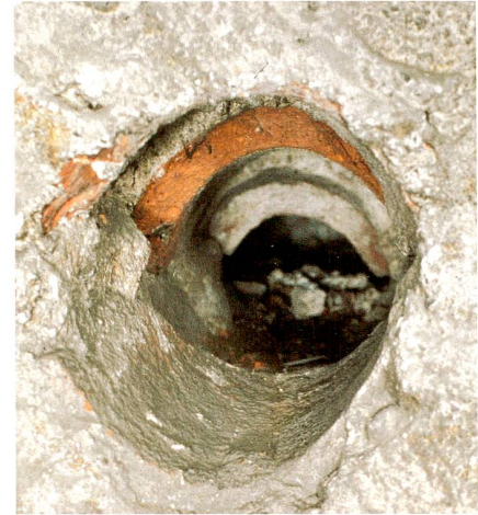
Abb. 59 Zug, Kolinplatz 12, Zitturm, drittes Obergeschoss. Mit Hohlziegeln ausgekleidete Öffnung im Mauerwerk von 1480 für die Zeigerwelle in der Südwestfassade.
