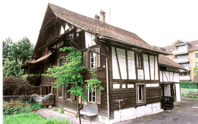
Abb. 11 Baar, Leihgasse 39/41. Der 1664/65 errichtete Ständerbau vor dem Abbruch im Jahr 2010. Blick nach Nordwesten.
