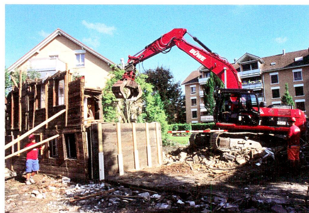
Abb. 14 Baar, Leihgasse 39/41. Bergung der bemalten Ostwand der Bohlenstube.
