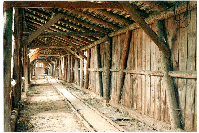
Abb. 40 Unterägeri, Lidostrasse 21, ehemaliger Seilerschopf. Die Seilerbahn vor dem Abbau, Blick nach Westen.
