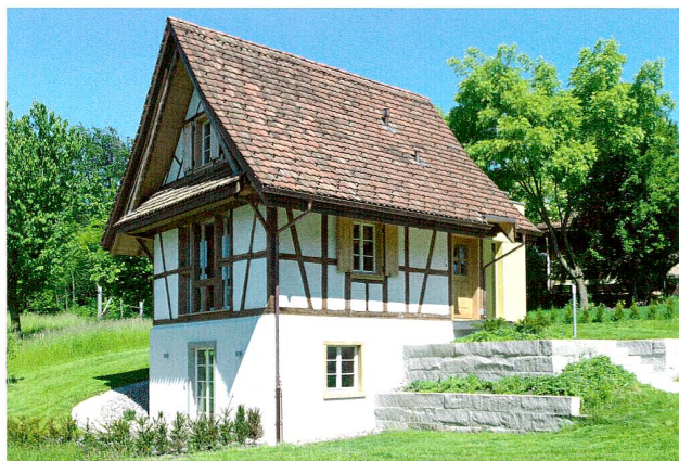
Abb. 8 Baar, Bofeld 4, ehemaliges Dörrhaus. Ansicht von Südosten.
