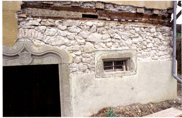
Abb. 47 Zug, Hofstrasse 42, Oberer Roost, Wohnhaus, Blick nach Osten. Türsturz mit Jahreszahl 1591, den Initialen «HB», dem Wappen der Familie Brandenburg und einem Steinmetzzeichen (Jost Knopflin?). Auf dem Sockelmauerwerk lag die Stubenschwelle von 1591 mit dem Triebbladenloch. Der Zwischenraum zwischen Mauerkrone und Schwelle war von aussen gestopft. Über der Schwelle ersetzte eine Fachwerkkonstruktion wahrscheinlich von 1811/12 die ehemalige Blockwand.
