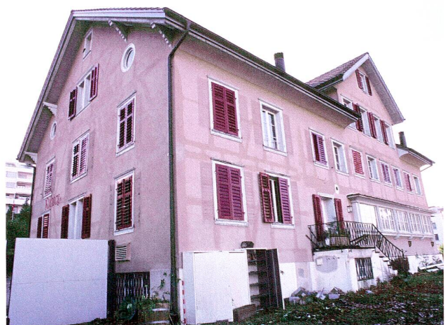
Abb. 66 Zug, Rosenbergstrasse 30, ehemaliges Restaurant Rosenberg, kurz vor dem Abbruch 2010. Wegen der Feuchtigkeit zeichnet sich unter dem Verputz das Fachwerk von 1578-81 und des 19. Jahrhunderts ab. Blick nach Südosten.
