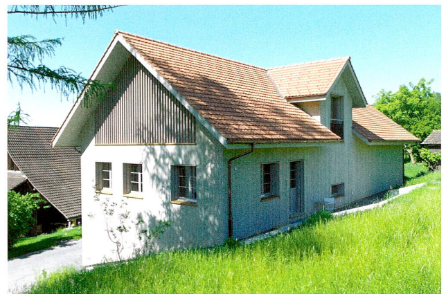
Abb. 9 Baar, Bofeld 2, Ökonomiegebäude. Ansicht von Nordosten.
