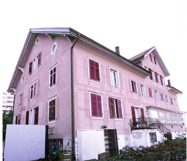
Abb. 66 Zug, Rosenbergstrasse 30, ehemaliges Restaurant Rosenberg, kurz vor dem Abbruch 2010. Wegen der Feuchtigkeit zeichnet sich unter dem Verputz das Fachwerk von 1578–81 und des 19. Jahrhunderts ab. Blick nach Südosten.
