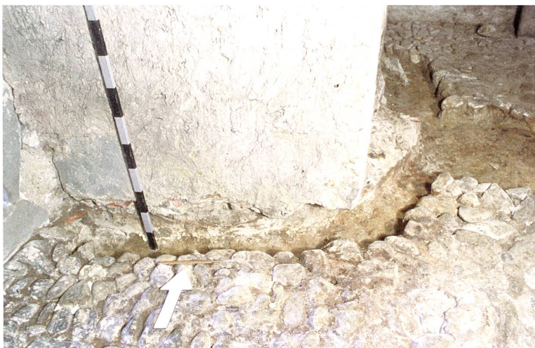
Abb. 49 Zug, Hofstrasse 42, Oberer Roost, Wohnhaus. Rest des Fundaments der im Grundriss runden Wendeltreppe unter dem Fundament der jüngeren Kellertreppe.
