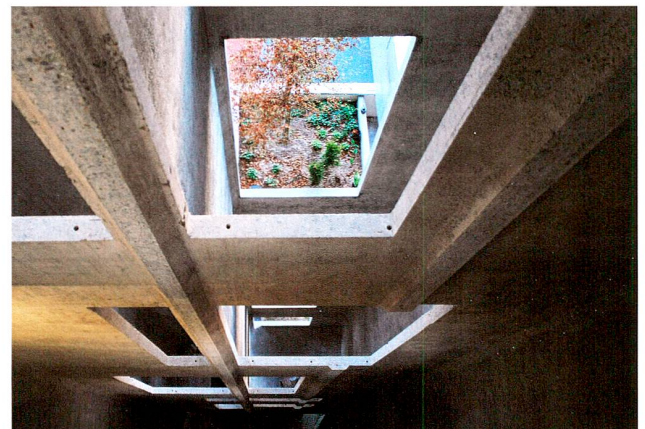
Abb. 20 Baar, Obermühle, ehemaliger Getreidesilo. Innenansicht der neuen Erschliessungsanlage.
