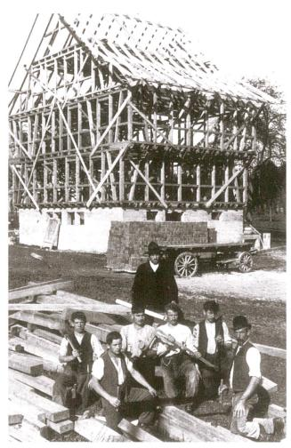
Abb. 12 Ständerbau in Cham nach der Aufrichte, 1923.
