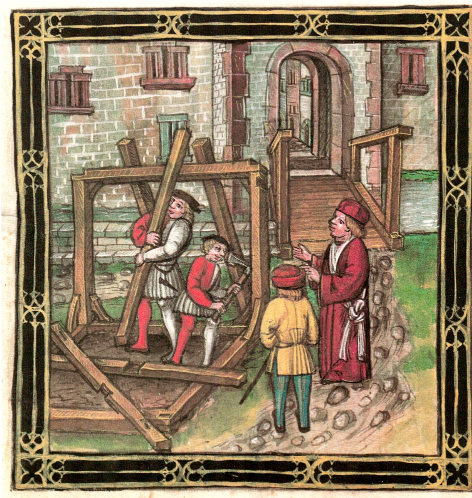
Abb. 1 Zimmerleute beim Zusammen- setzen eines Ständerbaus. Darstellung in der Luzerner Chronik von Diebold Schilling, 1513 (fol. 321v).
