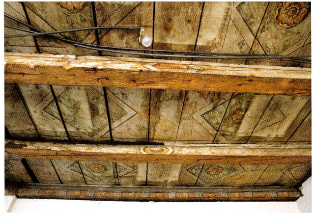
Abb. 41 Zug, Ägeristrasse 5. Bemalte Decke im zweiten Obergeschoss, möglicherweise um 1768.
