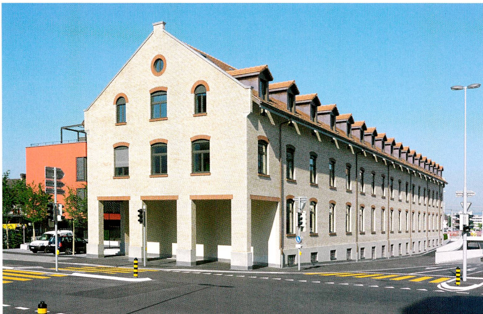
Abb. 44 Zug, Baarerstrasse 113, «Indukta». Ansicht von Osten, nach der Rekonstruktion.
