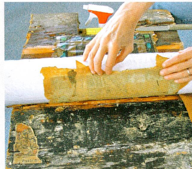
Entfernung des Druckes von der Trägerwand mittels einer grossen Rolle.
