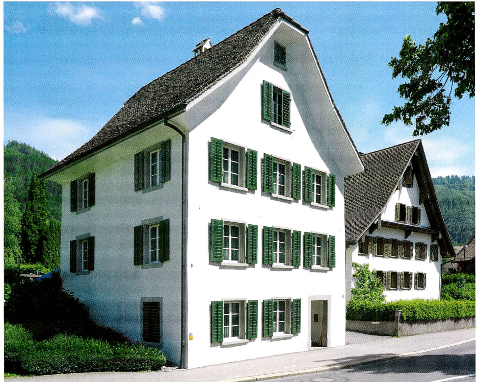
Abb. 48 Zug, Oberwil, Artherstrasse 107, Kaplanenhaus. Ansicht von Nord- westen.
