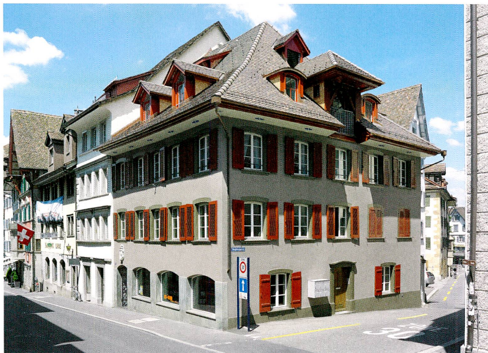
Abb. 42 Zug, Ägeristrasse 5, Wohnhaus. Ansicht von Südosten.
