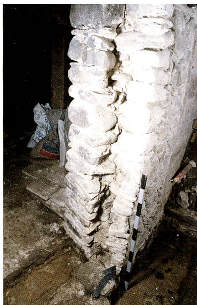
Abb. 34 Unterägeri, Chammersbüel. Bei der Unterkellerung des Hinterhauses musste hinter der älteren Kellermauer (rechts) eine Vormauerung errichtet werden.
