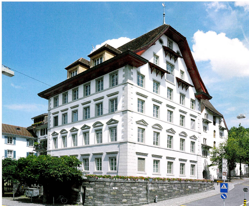
Abb. 50 Zug, St.-Oswalds-Gasse 20, Baudepartement. Ansicht von Südwesten.
