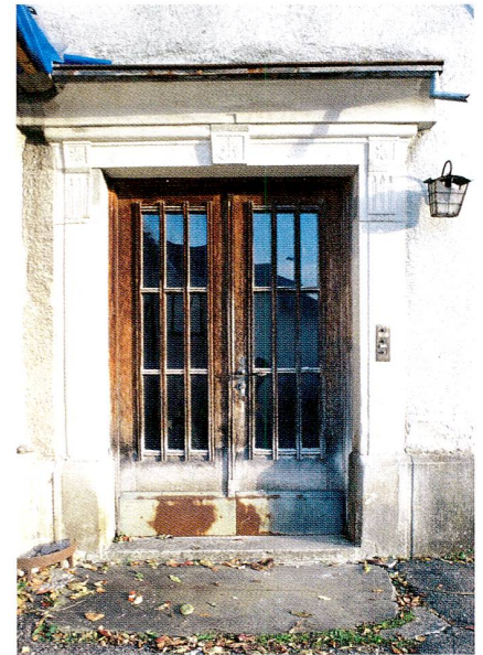
Abb. 21 Menzingen, Neudorfstrasse/Alte Landstrasse, Haus Weber. Hauseingang von 1903. Der Türsturz mit der Jahreszahl 1766 und dem Wappen der Familie Weber war eine Spolie.
