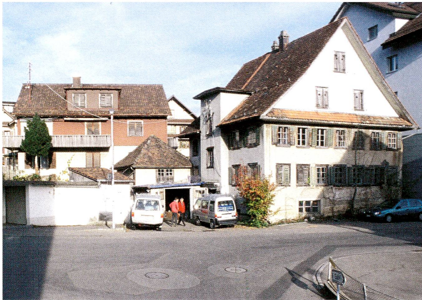
Abb. 20 Menzingen, Neudorfstrasse/Alte Landstrasse, Haus Weber. Die 2009 abgebrochenen Gebäude im Dorfkern von Menzingen, Ansicht von Süden.
