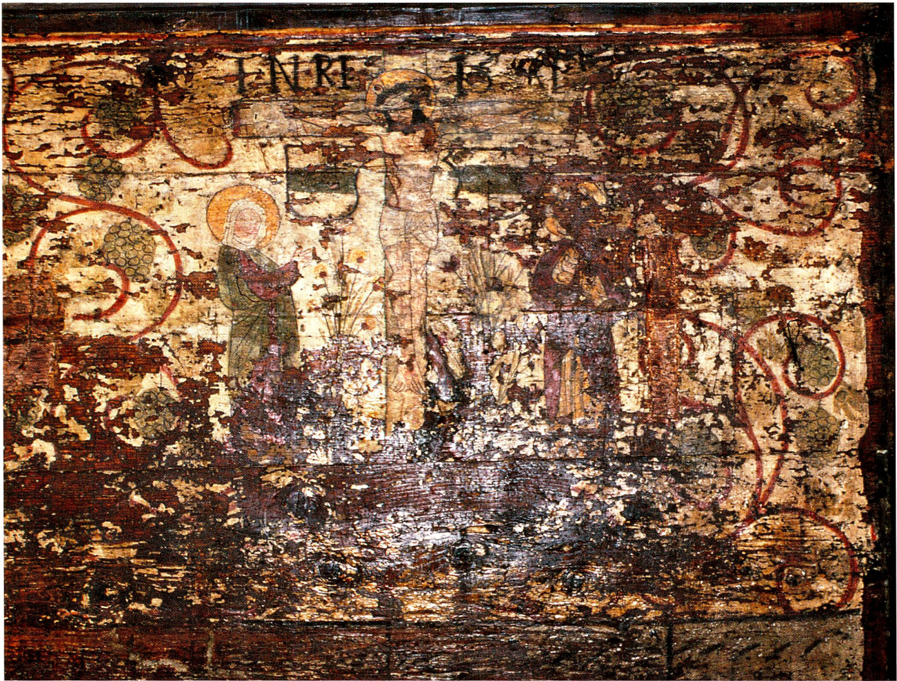
Abb. 4 Zug, Grabenstrasse 20. Erstes Obergeschoss, Westraum, südliche Bohlenwand. Kreuzigungsszene mit ornamentalen Begleitmalereien, 1541
