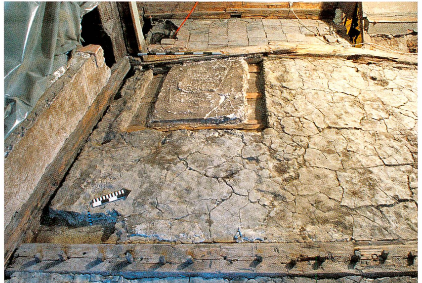
Abb. 8 Zug, St.-Oswalds-Gasse 10. Erstes Obergeschoss, Raum 10. Auf dem originalen Lehm Mörtel-estrich, in dem das Negativ des Ofenfundaments noch sichtbar ist, lagen zahlreiche Leder-schnipsel, Münzen und andere Funde. Der Mörtelguss stösst an die Aussenschwellen sowie an die Setzlatte (vorne), welche die Raumfläche teilt. Darin stecken noch die Holznägel, mit denen die Bodenbretter befestigt waren.
