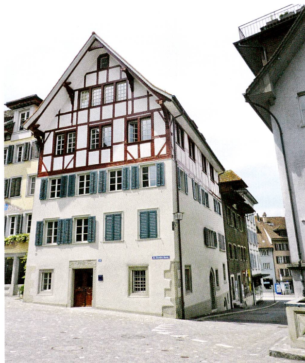
Abb. 1 Zug, St.-Oswalds-Gasse 10. Ost- und Nordfassade (rechts).
