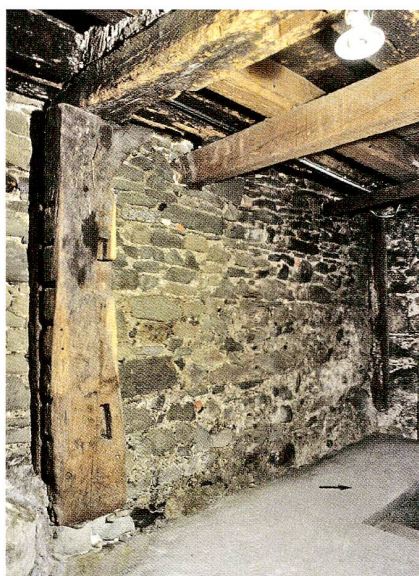
Abb. 4 Zug, St.-Oswalds-Gasse 10. Erdgeschoss, Raum 9, Südwand. Auf dem originalen Mittelständer liegt der Unterzug auf. Die vertikale Nut im Ständer und das Kopfholz auf der Ständeraussenseite sind noch vorhanden. Sekundär sind der Steinsockel und das Fundament unter dem Ständer sowie die von aussen an den Bohlenständerbau gemauerte Steinwand, in der horizontale Negative von Wandbohlen sichtbar sind.
