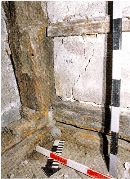
Abb. 7 Zug, St.-Oswalds-Gasse 10. Erstes Obergeschoss, Raum 10, Südwestecke. Der originale Ständer ist mit Fase und auslaufendem Schildchen verziert. Er ist in die südliche Aussenschwelle (links) eingezapft, in welche die westliche Innenschwelle (rechts) stösst. Die Deckenbretter laufen unter der Innenschwelle durch, in der Aussenschwelle sind sie eingefalzt. Über der Oberkante des bereits entfernten Mörtelgusses sind die Nuten zur Aufnahme der Bodenbretter sichtbar.
