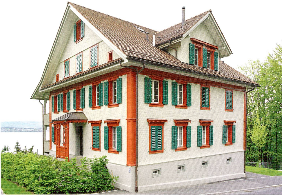
Abb. 58 Zug, Zugerbergstrasse 38, Wohnhaus. Ansicht von Süden.
