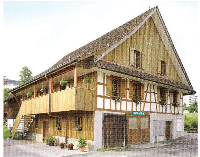
Abb. 43 Zug, Rüschenhof 3, Ökonomiegebäude. Ansicht von Norden.
