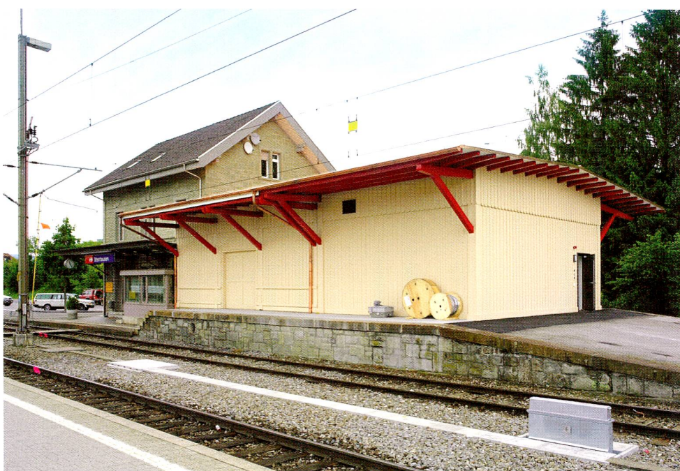
Abb. 18 Steinhausen, Bahnhofgebäude. Erweiterung Lagerschuppen. Ansicht von Süden.
