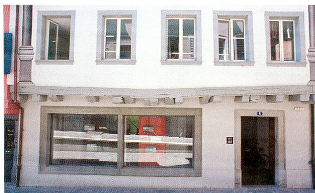
Abb. 41 Zug, Oberaltstadt 4. Ostfassade, Blick nach Südwesten. Jeder zweite vorkragende Deckenbalken des Erdgeschosses, die Bodenbretter und die Schwelle des ersten Obergeschosses gehören zu einem 1371 erbauten Bohlen-Ständer-Bau. Die anderen Deckenbalken des Erdgeschosses wurden 1668/69 gefällt.
