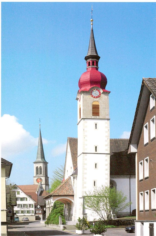
Abb. 19 Unterägeri, Alte Landstrasse 100, Kirche St. Maria, Kirchturm. Nach der Restaurierung. Ansicht von Osten.
