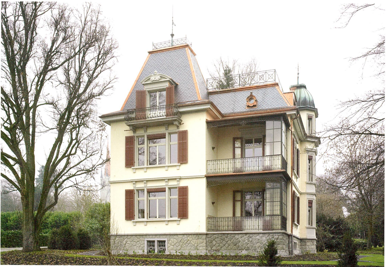
Abb. 31 Zug, Artherstrasse 19, Villa Stadlin. Ansicht von Westen.
