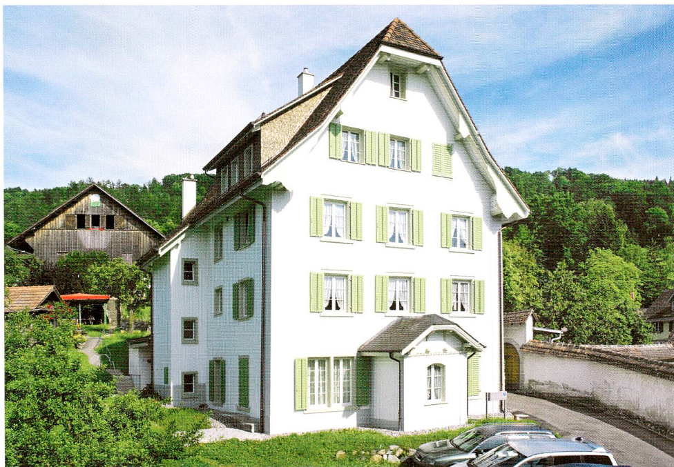
Abb. 37 Zug, Klosterstrasse 6, Pächterhaus. Ansicht von Westen.
