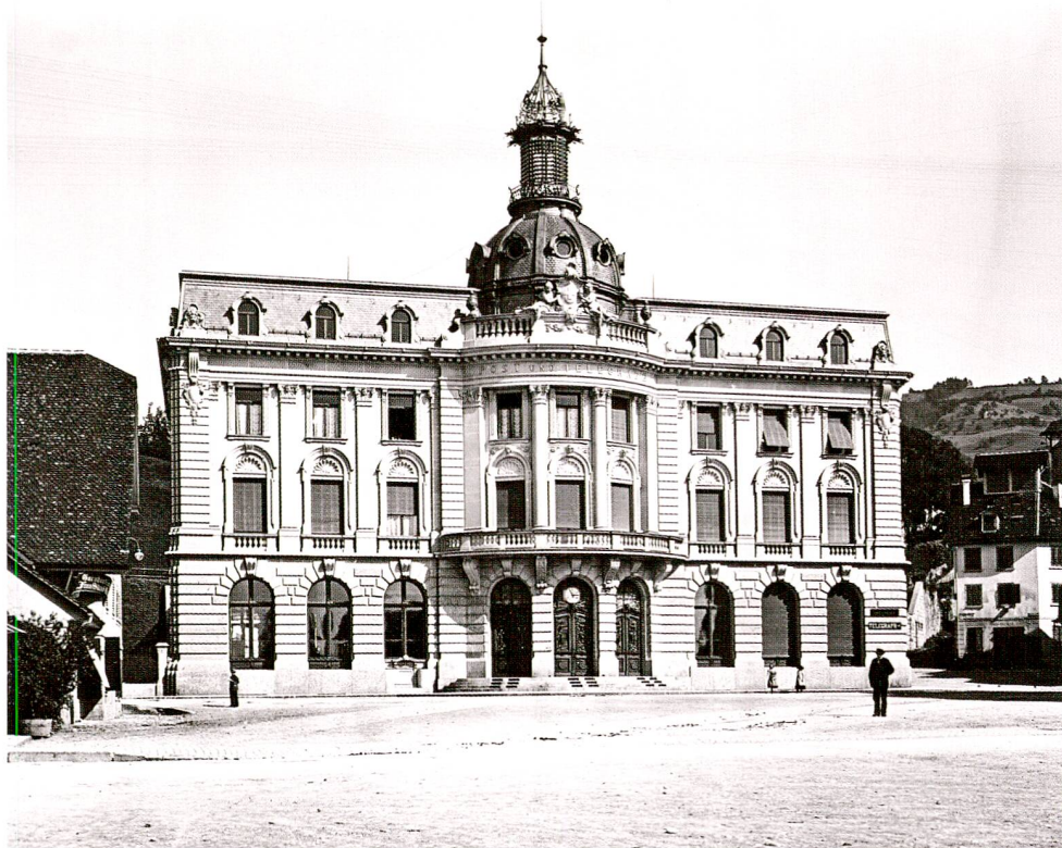
Abb. 13 Das 1902 eröffnete Postgebäude am Postplatz in Zug, erbaut im Stil der italienischen Renaissance. Die hohe Zentralkuppel ist in Holz und Eisen konstruiert, die Fassaden aus geschliffenem Sandstein.
