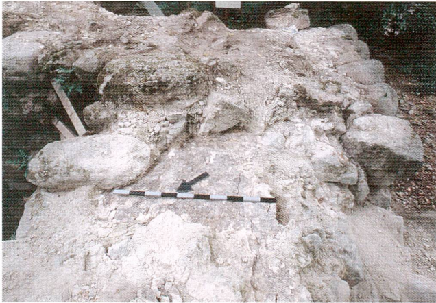
Abb. 18 Burgruine Hünenberg, Westmauer des Bergfrieds. Das Mauerwerk enthält hier wegen eines Bauunterbruchs eine horizontale Fuge (so genannte Wintergrenze). Brandspuren auf der Mörteloberfläche in der Fuge zeugen davon, dass die Mauer zum Schutz vor Frost mit Stroh und Reisig, das später offenbar Feuer gefangen hat, abgedeckt worden ist (beim Massstab). Blick Richtung Süden, 2007.
