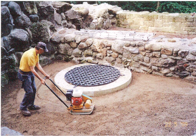
Abb. 28 Burgruine Hünenberg. Abschluss der Restaurierung des Sodbrunnens im Frühjahr 2009.
