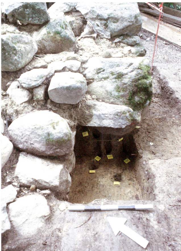
Abb. 19 Burgruine Hünenberg. Der massive Stützpfiler im Süden der Anlage wurde mit zahlreichen Staketen gegen das Absinken gesichert. Die gelben Zettel markieren die Negative der Staketen. Blick nach Osten, 2008.
