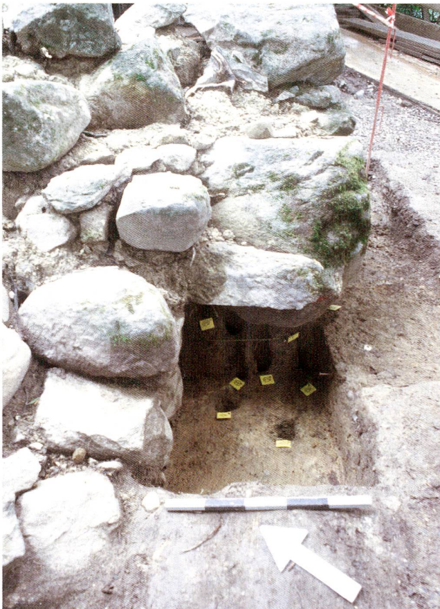
Abb. 19 Burgruine Hünenberg. Der massive Stützpfiler im Süden der Anlage wurde mit zahlreichen Staketen gegen das Absinken gesichert. Die gelben Zettel markieren die Negative der Staketen. Blick nach Osten, 2008.
