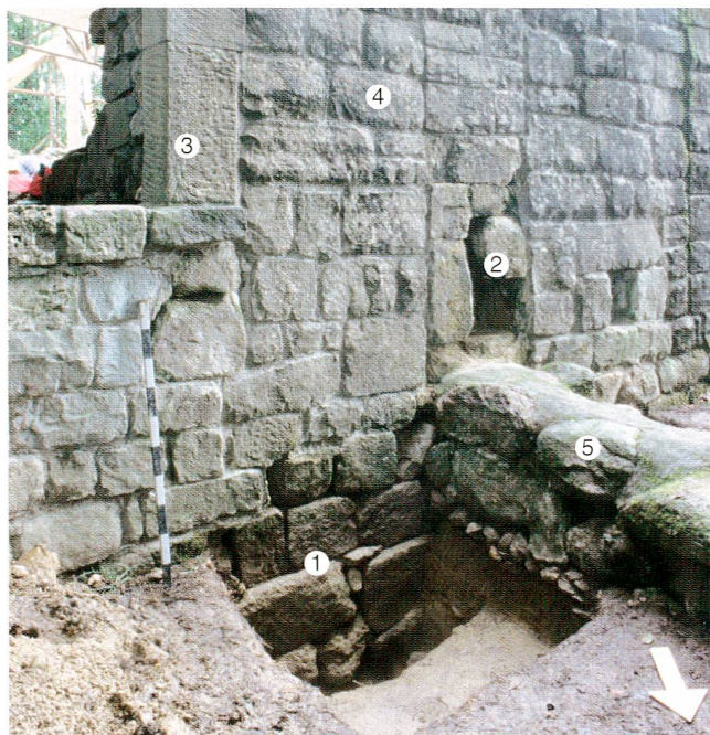
Abb. 13 Burgruine Hünenberg. Ehemalige Innenseite der Südmauer des Palas, 2007. 1 Originales Quadermauerwerk mit Fundamentabsatz, auf einer ohne Mörtel verlegten Fundamentlage aus Kiesel (Phase I). 2 Pfeiler im rekonstruierten Mauerwerk, der ebenso zu Phase I gehört und zwischen zwei Arkaden stand, die im Zusammenhang mit einer Niveauanhebung in Phase III zugemauert wurden. 3 In Phase III gebaute, höher liegende Türe. 4 Mauer, die in Phase III zur Nordfassade der Burg wurde. 5 Mauerfundament, ebenfalls jünger als die Quadermauer.
