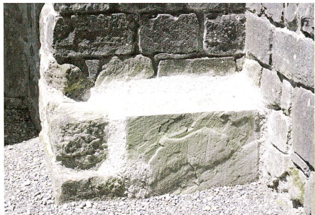
Burgruine Hünenberg. Mauerecke (vgl. Abb. 31, M6/M7). 1 Vor der Restaurierung. 2 Mit reversibler Vormauerung zum Schutz originaler Sandsteinquader.
