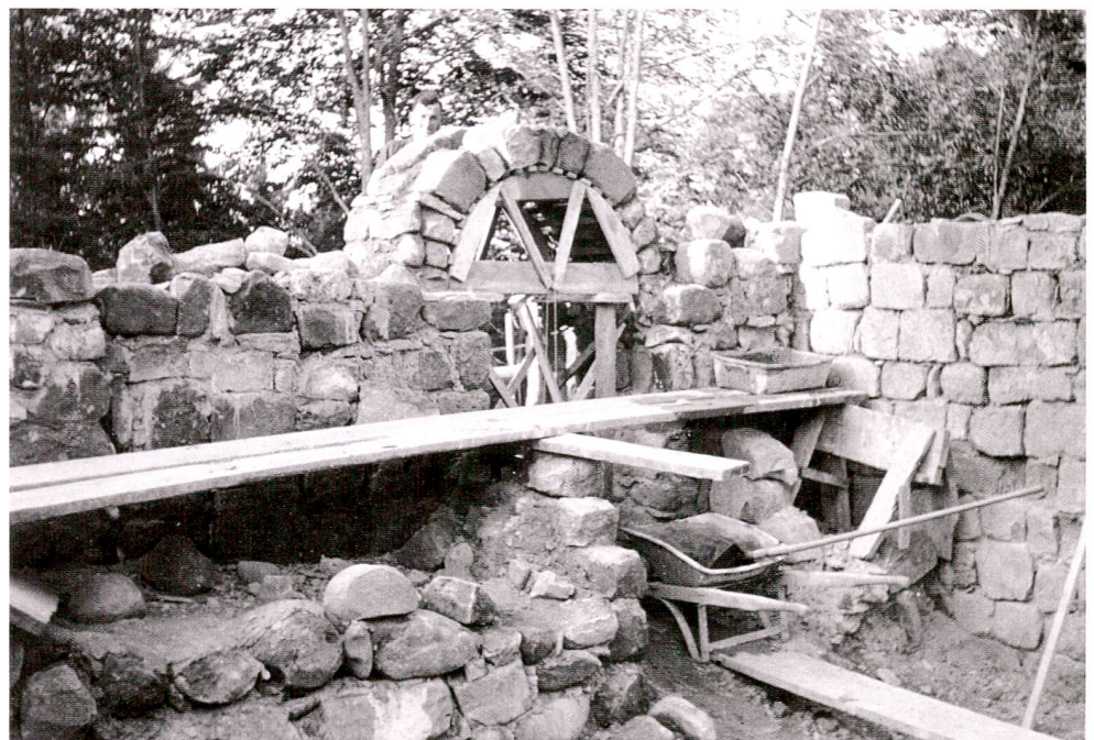
Abb. 6 Burgruine Hünenberg. Wiederaufbauarbeiten nach Abschluss der Ausgrabungen 1947. Blick Richtung Norden.
