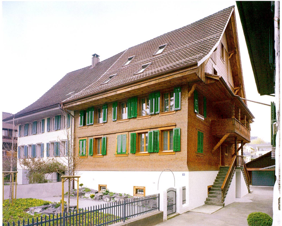
Abb. 3 Baar, Blickensdorferstrasse 10, Wohnhaus. Ansicht von Süden.
