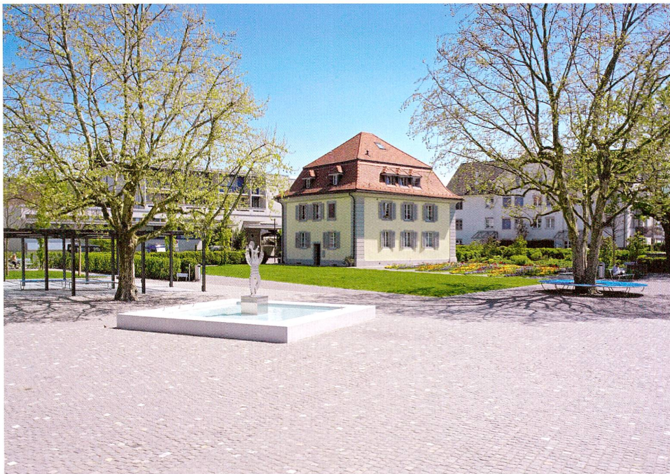
Abb. 7 Baar, General-Andermatt-Haus. Umgebungsgestaltung zwischen Leihgasse und Schulhaus Markt- gasse.
