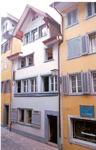
Abb. 40 Zug, Oberaltstadt 13, Wohnhaus. Ein 1472 errichtetes Haus bildet bis heute den Kern des Gebäudes. Ansicht von Nordosten.
