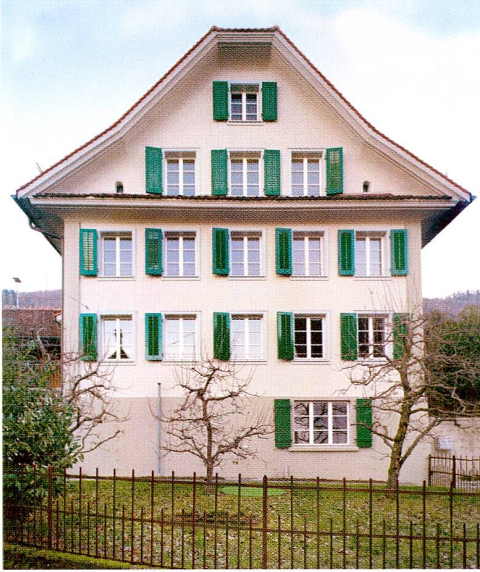
Abb. 30 Walchwil, Dorfstrasse 15, Altes Pfarrhaus. Ansicht von Südwesten.
