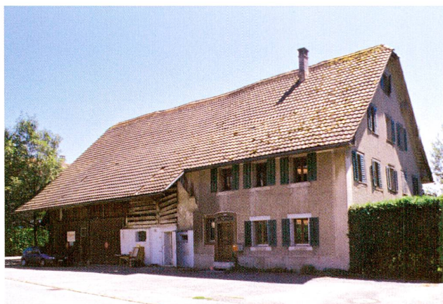
Abb. 8 Baar, Leihgasse 32, Bauernhaus. Das 2007 abgebrochene Vielzweck- haus. Ansicht von Nordwesten.
