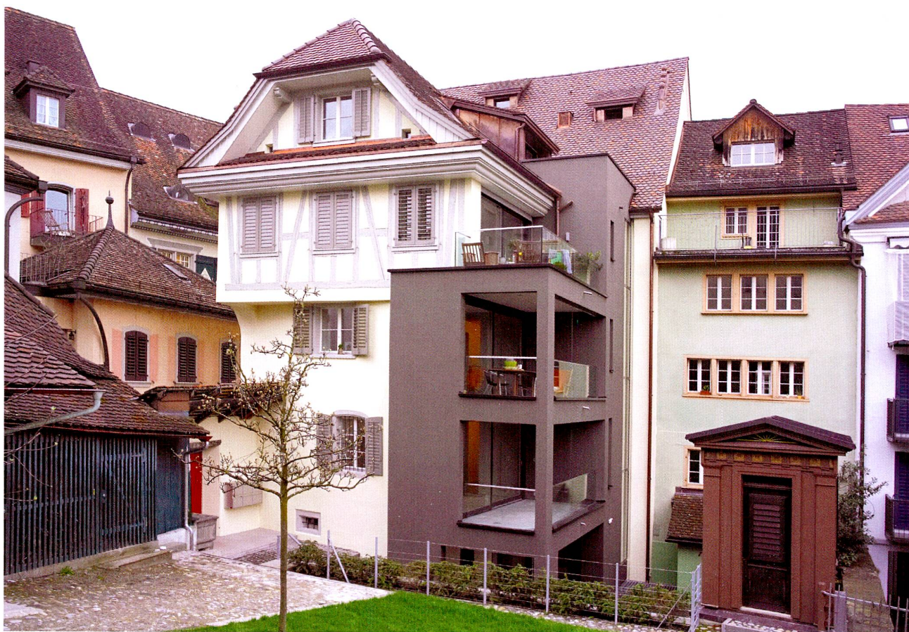
Abb. 50 Zug, Zeughausgasse 21, Wohn- und Geschäftshaus, Anbau. Ansicht von Nordosten.
