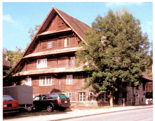
Abb. 4 Baar, Blickensdorferstrasse 21, Wohnhaus. Der Bohlen-Ständer-Bau von Südosten. Das Haus stammt im Kern aus der Zeit nach 1516 und wurde 1775/76 massiv umgebaut.
