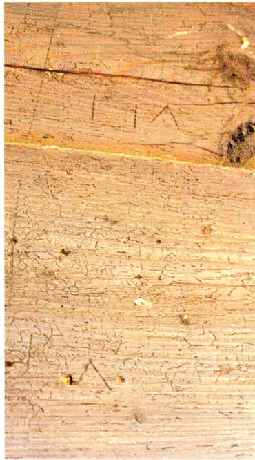
Abb. 42 Zug, Oberwil, Artherstrasse 125/127, Wohnhaus. Die eingekerbten Nummerierungszeichen an der Nordfassade beim Hauseingang sind ein Hinweis auf die Versetzung des Blockbaus.
