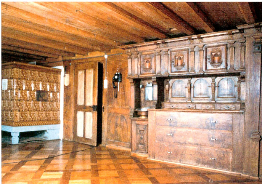
Abb. 25 Oberägeri, Eggstrasse 57, Haltenbüel, Bauernhaus. Die Stube mit der Bohlen-Balken-Decke, dem Renaissancebuffet und dem Kachelofen.
