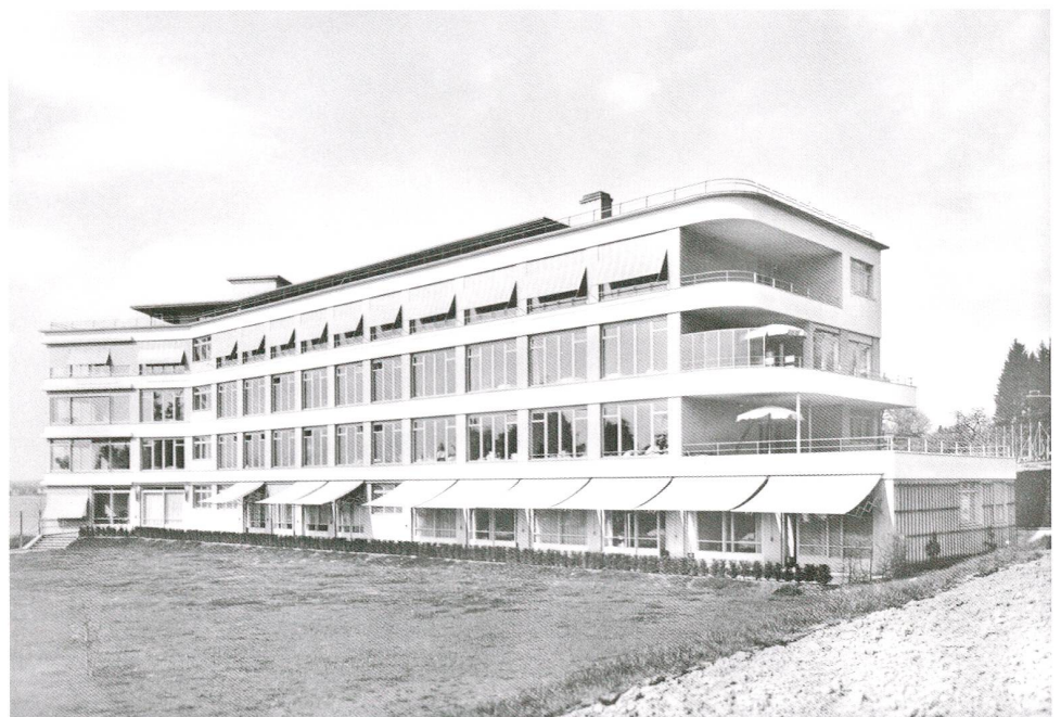
Abb. 33 Zug, Artherstrasse 25/27, Kantonsspitalareal. Bettentrakt von 1934–37. Ansicht von Süden, Aufnahme um 1937.
