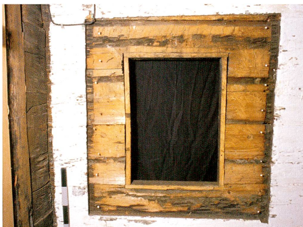
Abb. 8 Oberägeri, Hintergrueben. Eingangsbereich (Raum 3). Nordseite der Binnenwand zur Stube. In der Mitte ist die rechteckige Öffnung des Wandschranks in der Stube («Pestfenster») zu sehen, darum herum das Negativ des dazugehörigen Kastens mit horizontalen Abdrücken der Tablare.
