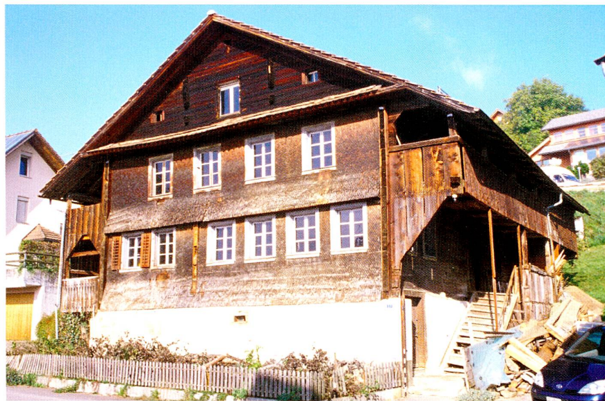
Abb. 2 Oberägeri, Hintergrueben. Giebelseite des dreigeschossigen Gebäudes. Das steinerne Sockelgeschoss wurde als Keller genutzt, der Zugang in die Wohnräume führte über eine Laube auf der rechten Seite.
