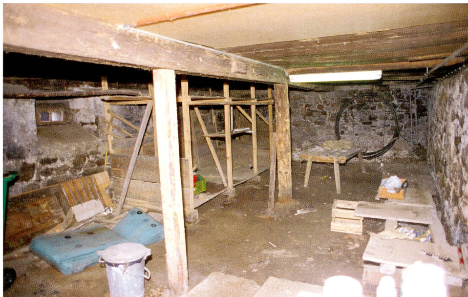
Abb. 4 Oberägeri, Hintergruben. Blick vom Eingang auf der Ostseite ins Innere des steinernen Sockel- geschosses. In der Mitte der original eingemauerte Unterzug, links das einzige Fenster.
