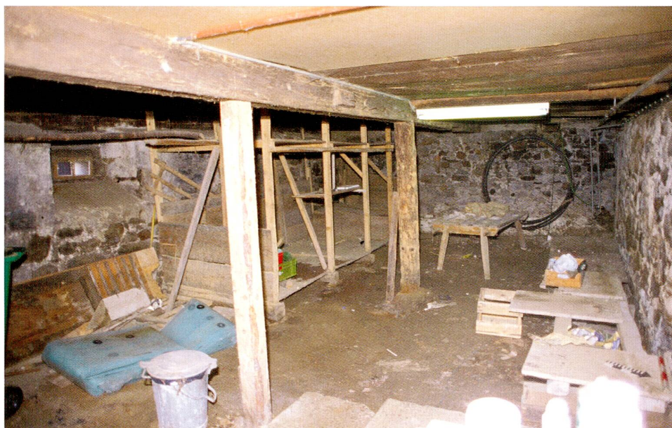
Abb. 4 Oberägeri, Hintergrueben. Blick vom Eingang auf der Ostseite ins Innere des steinernen Sockelgeschosses. In der Mitte der original eingemauerte Unterzug, links das einzige Fenster.
