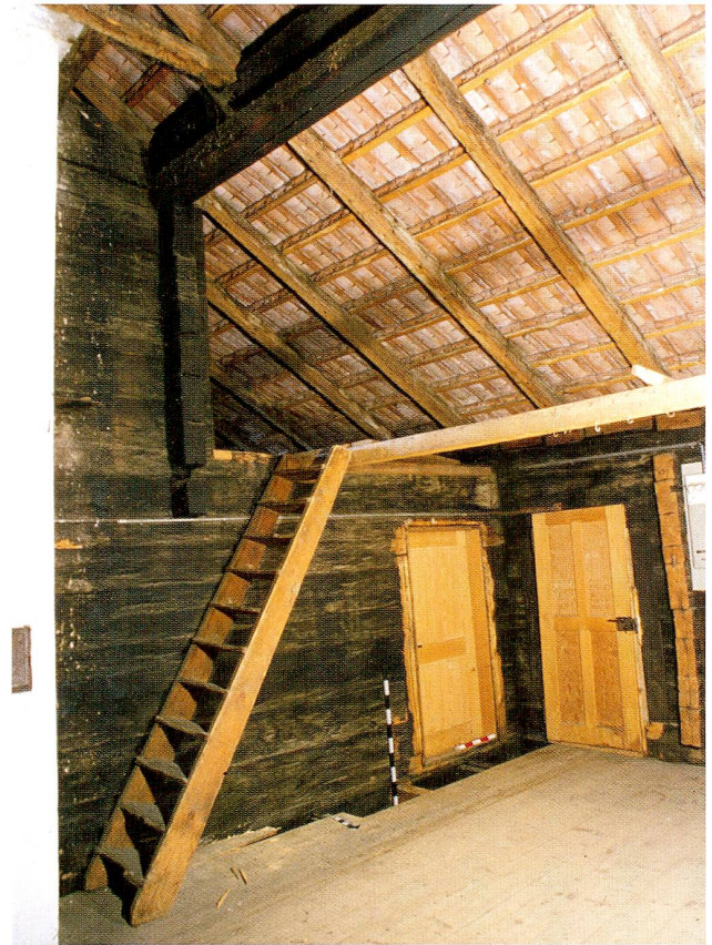
Abb. 12 Oberägeri, Hintergrueben. Rechts der Ausgang zur westlichen Laube, daneben die abgesägten Balken der ehemaligen Hinterkammer. Links unten die südlichen Räume des zweiten Wohngeschosses, davor der Aufgang zur Dachkammer. Oben die rauchgeschwärzte originale Mittelpfette mit aufgedoppeltem Balken (ehemalige Fusspfette) für den jüngeren Dachstuhl.
