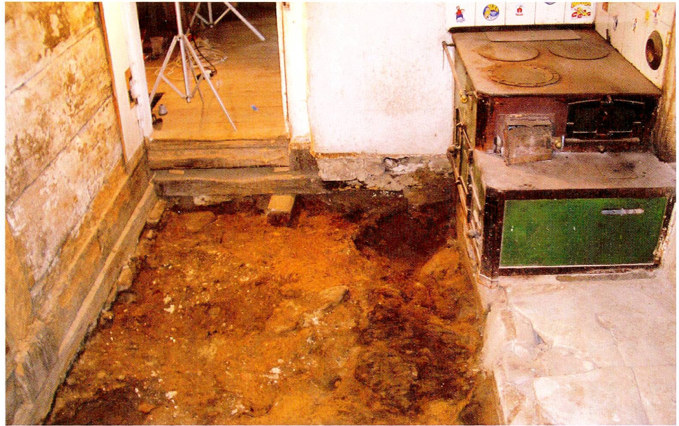
Abb. 14 Oberägeri, Hintergruben. Küche (Raum 6). Rechts der eiserne Sparherd aus der Zeit um 1900, darunter der gemauerte Sockel einer älteren Herdstelle. Im Vordergrund das ca. 30 cm tiefer liegende, ältere Bodenniveau.
