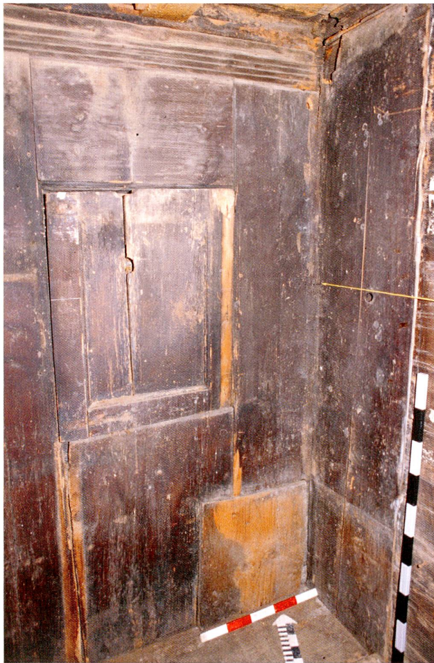
Abb. 7 Oberägeri, Hintergrueben. Stube (Raum 4). Detailansicht der nördlichen Binnenwand mit der Aussparung für den ehemaligen Wandschrank («Pestfenster»). Über dem Wandschrank befindet sich ein mit Rillenfries verzierter Auflagebalken der ehemaligen Bohlen-Balkendecke. Unten ein mit einem hellen Brett verschlossenes Negativ einer Sitzbank, ganz rechts die Bohlenwand hinter dem Bretttäfer.
