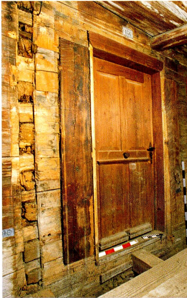
Abb. 5 Oberägeri, Hintergrueben. Erstes Wohn- geschoss, Laube. Rechts des jüngeren Tür- gerichts ist der aus der Bauzeit stammende Mantelstud der älteren Türe sichtbar. Links die abgearbeiteten Blockvorstösse der zen- tralen Binnenwand.
