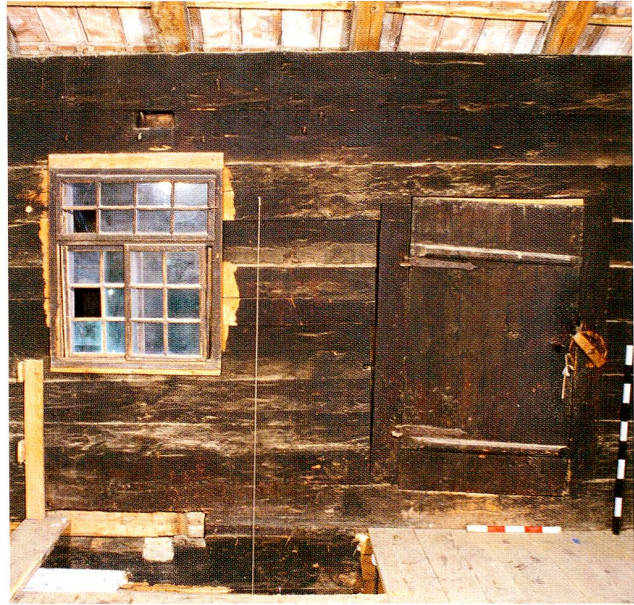
Abb. 10 Oberägeri, Hintergruben. Zweites Wohngeschoss, Nordteil (Raum 10). Ostfassade (Innenseite) mit originalem Türgerüst und Türblatt des Ausgangs zur Laube. Die beiden Türpfosten sind etwa 8 cm tief ins Sturzholz eingeschnitten. Links der Türe ein ehemaliges, wieder verwendetes Stubenfenster aus dem 18. Jahrhundert.
