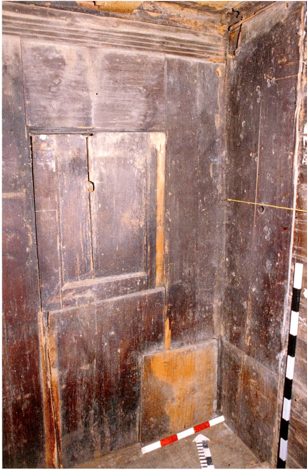
Abb. 7 Oberägeri, Hintergrueben. Stube (Raum 4). Detailansicht der nördlichen Binnenwand mit der Aussparung für den ehemaligen Wandschrank («Pestfenster»). Über dem Wandschrank befindet sich ein mit Rillenfriess verzierter Auflagebalken der ehemaligen Bohlen-Balkendecke. Unten ein mit einem hellen Brett verschlossenes Negativ einer Sitzbank, ganz rechts die Bohlenwand hinter dem Bretttäfer.
