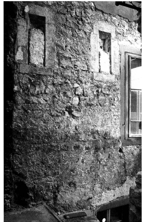
Abb. 12 Der Sockel des Lughauses (Nordostfassade) während der Bauuntersuchung 1983. Rechts der Zitturm mit Strebe Pfeiler, links das Lughaus mit einem der beiden Schlitzfenster. Blick nach Süden.
