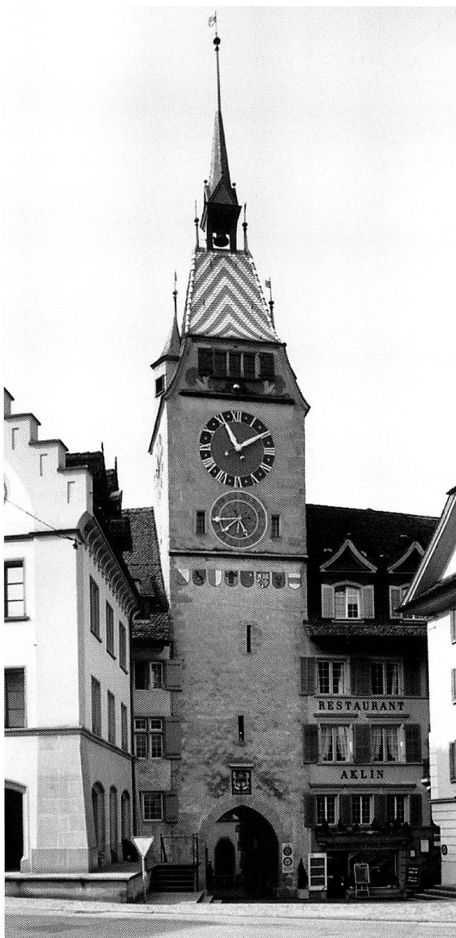
Abb. 11 Zitturm. Unterhalb der aufgemalten Kantonswappen zeichnet sich besonders anhand der unterschiedlichen Eckverbände die Grenze zwischen dem originalen Mauerwerk und der Aufstockung ab. Links das Zollhaus und dazwischen nur knapp sichtbar das Lughaus. Blick nach Südwesten.
