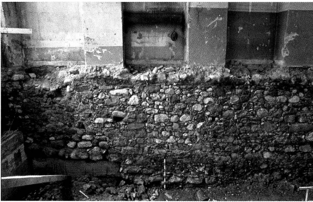
Abb. 15 Ansicht an die Zwingermauer unter dem Polizeigebäude (Kolinplatz 4). Links der ältere Bestand, rechts der jüngere, tiefer fundierte Flick. Blick nach Südwesten. Aufnahme 1981.
