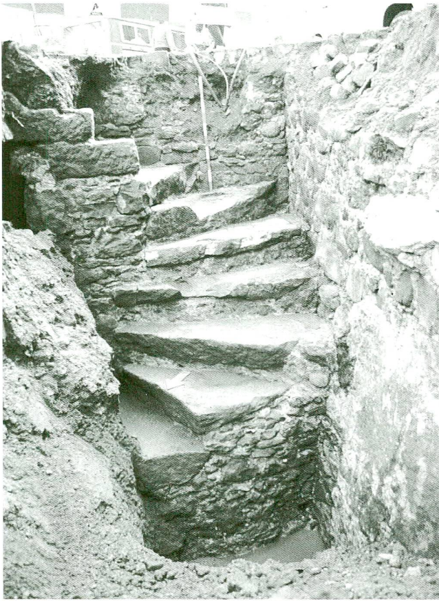
Abb. 18 Das Untergeschoss des Wehrbaus im Stadtgraben war über eine Wendeltreppe zugänglich. Rechts die Zwingermauer. Blick nach Südosten. Aufnahme 1982.
