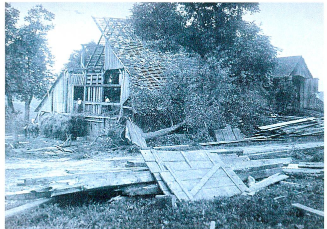
Abb. 6 Rotkreuz, Haldenhof. Die Scheune von Christian Wüthrich nach dem Sturm vom 4. Juli 1916.
