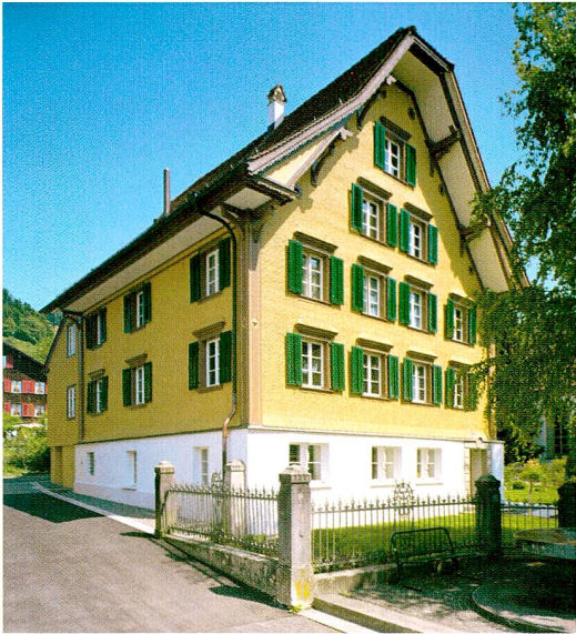
Abb. 21 Unterägeri, Alte Landstrasse 102, Pfarrhaus. Aussenansicht.
