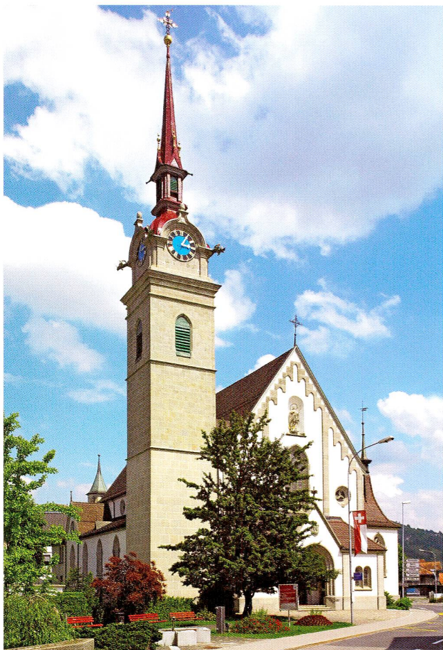
Abb. 15 Oberägeri, Pfarrkirche St. Peter und Paul. Gesamtansicht Kirchturm.
