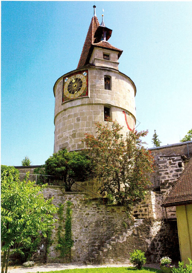
Abb. 38 Zug, Kapuzinergässli 1, Kapuzinerkloster. Treppenaufgang zum Turm.
