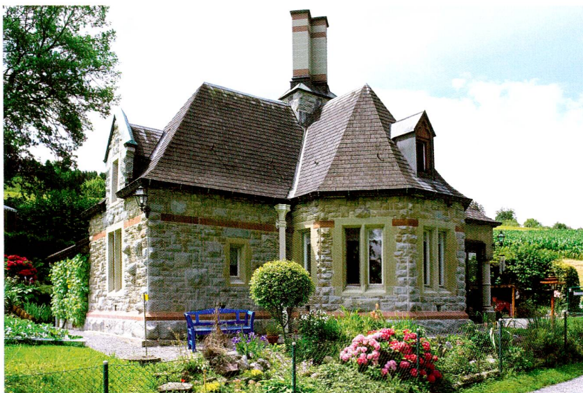
Abb. 19 Risch, Buonas, Schlosspark, Pförtnerhaus Nord. Aussenansicht.
