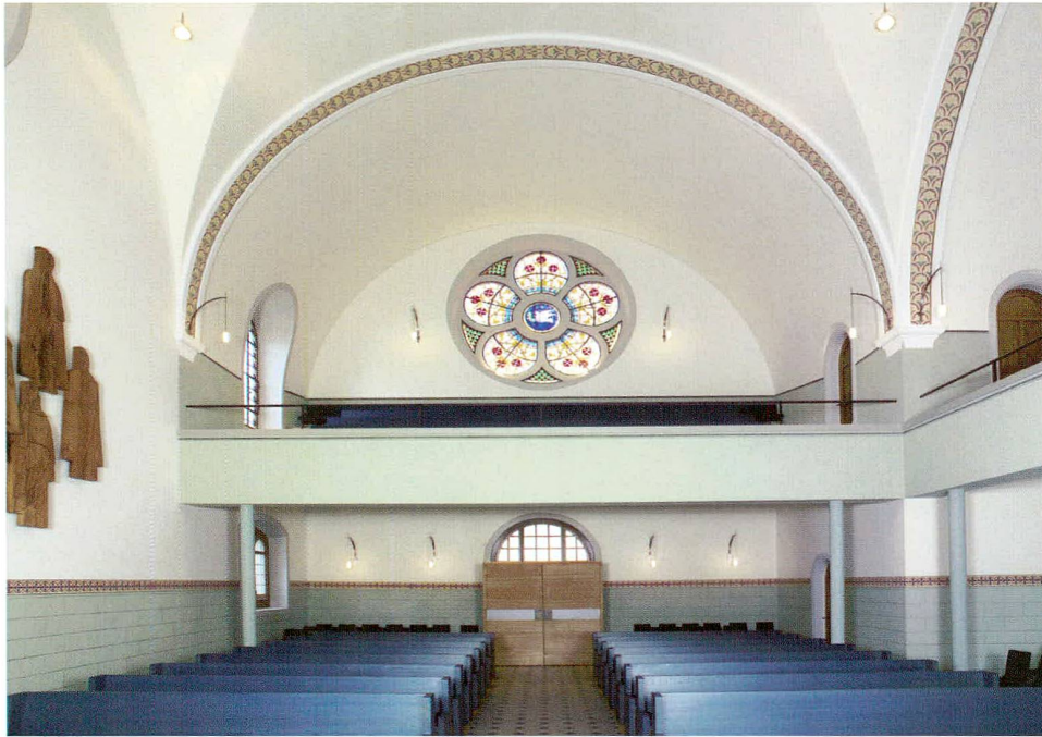
Abb. 6 Reformierte Kirche in Zug, Alpenstrasse. Ostwand mit dem Haupteingang, nach der Renovation von 2004–05.
