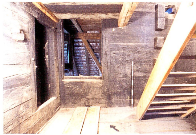
Abb. 13 Walchwil, Lauihof. Stichgang (Raum 17) im Obergeschoss mit dem Durchgang in die ehemalige Kammer über der Hinterstube. Links der Eingang in die Kammer über dem Nordteil der Küche (Raum 18). Blick nach Nordosten.
