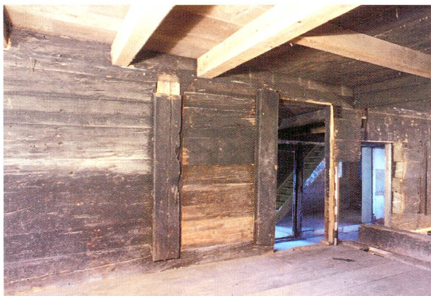
Abb. 11 Walchwil, Lauihof. Hinterstube (Raum 10) mit der ehemaligen, später zugebauten Türe, deren Pfosten als Mantelstüde ausgebildet waren. Rechts davon befand sich ein Ofen, dahinter die Küche (Raum 8) und zuhinterst die Treppe ins Obergeschoss. Blick nach Westen.
