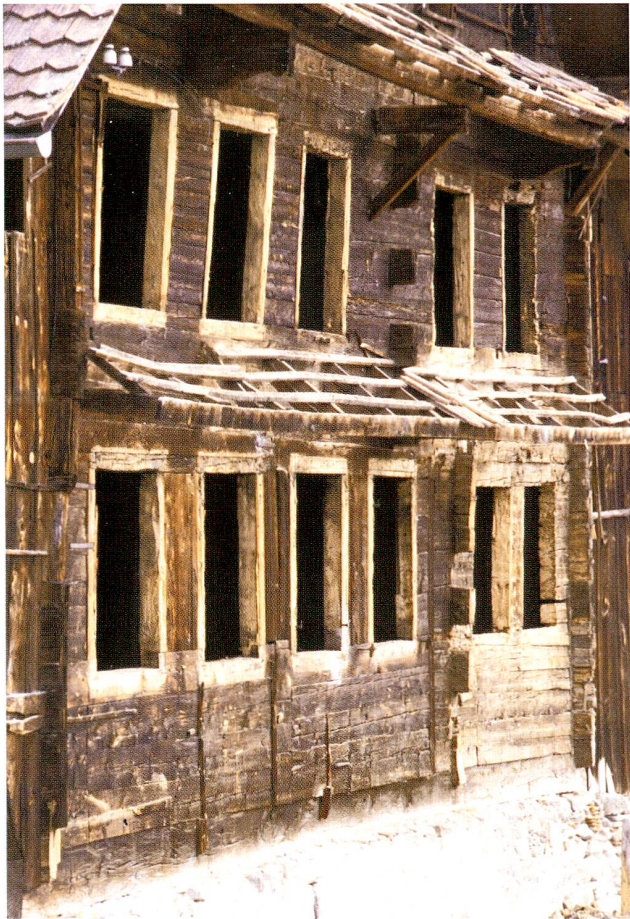
Abb. 16 Walchwil, Lauihof. Die zum Teil stark erneuerte Südwestfassade vor dem Abbruch. Deutlich zu erkennen sind die drei Einzelvorstösse der Wand zwischen den beiden Kammern im Obergeschoss. Die darüber liegenden Vordachträger mit sogenannten Rossköpfen sassen im Bestand des umgebauten Dachgeschosses.
