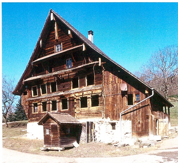
Abb. 3 Walchwil, Lauihof. Südwestfassade. Auf dem gemauerten Sockelgeschoss mit dem Keller erhebt sich der Blockbau und darüber das später neu erbaute Dachgeschoss. Die Stubenfassade ist zu einem grossen Teil nachträglich ersetzt.
