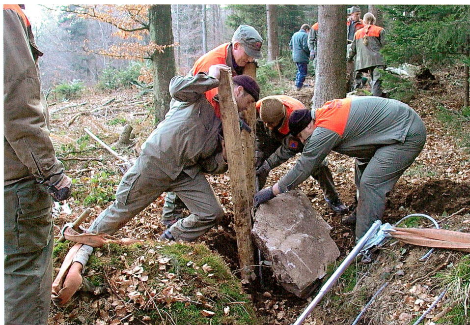
Abb. 9 Risch, Chilchberg, Steinreihe. Restaurierung 2004. Zivildienst- leistende im Einsatz.
