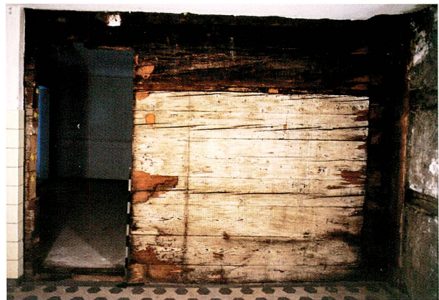
Abb. 19 Neugasse 29, zweites Obergeschoss. Ehemalige Ostfassade des Blockbaus.
