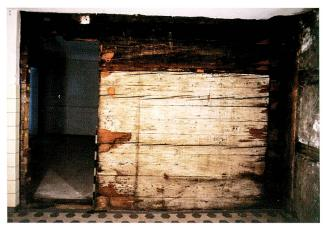
Abb. 19 Neugasse 29, zweites Obergeschoss. Ehemalige Ostfassade des Blockbaus.
