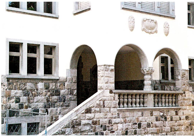
Abb. 6 Baar, Inwilerstrasse, Schulhaus Dorfmat, Eingangshalle von Norden.
