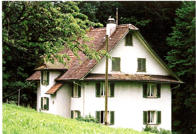
Abb. 33 Risch, Rischerstrasse, Rainhaus/Melkerhaus. Ansicht von Norden.
