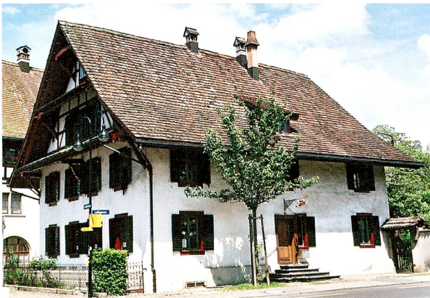
Abb. 8 Baar, Leihgasse 1, Wohnhaus. Ansicht von Süden.
