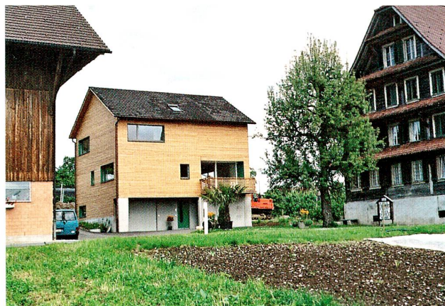
Abb. 17 Cham, Oberwil, Wohnhaus. Ansicht von Südwesten.
