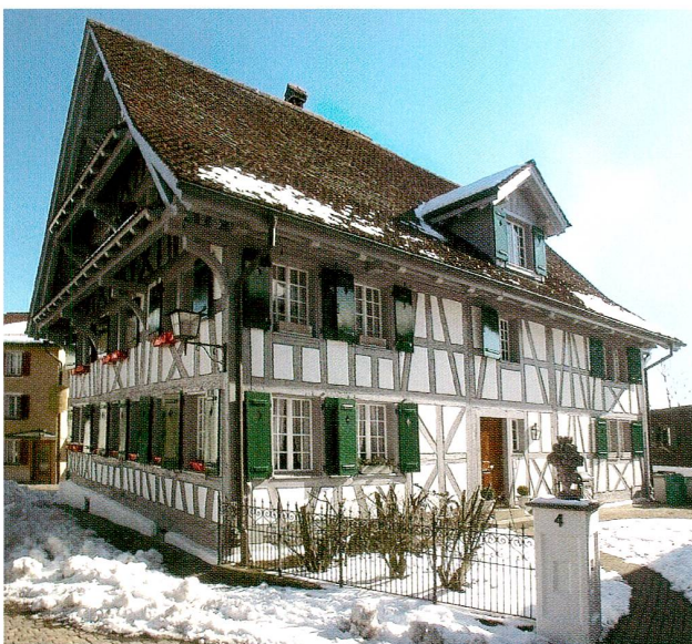
Abb. 28 Neuheim, Dorfstrasse 4, Schmiedhaus. Ansicht von Westen, nach der Fassadenrestaurierung von 2004.
