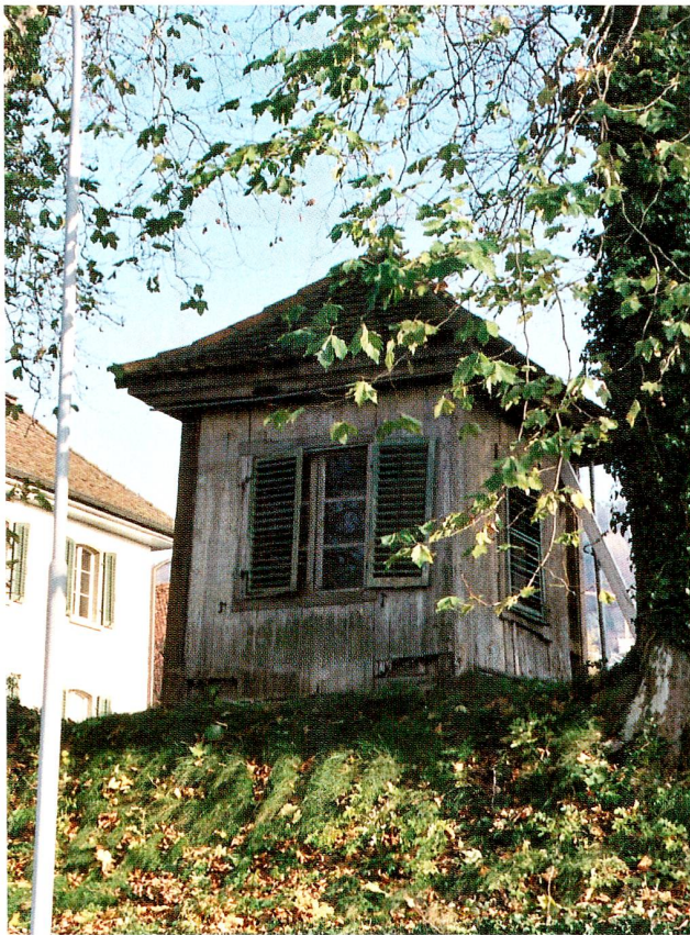
Abb. 38 Zug, Artherstrasse 33, Fideikommiss Müller im Roost. Ehemaliger Gartenpavillon. Ansicht von Südwesten.
