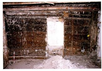
Zug, Vorstadt 14, Wohnhaus. Nordwand im Erdgeschoss. Der Ständer rechts, der Riegel mit der Nut für die Decke und die Wandbohlen gehören zur originalen Bausubstanz aus der Zeit um 1390 (Phase II).
