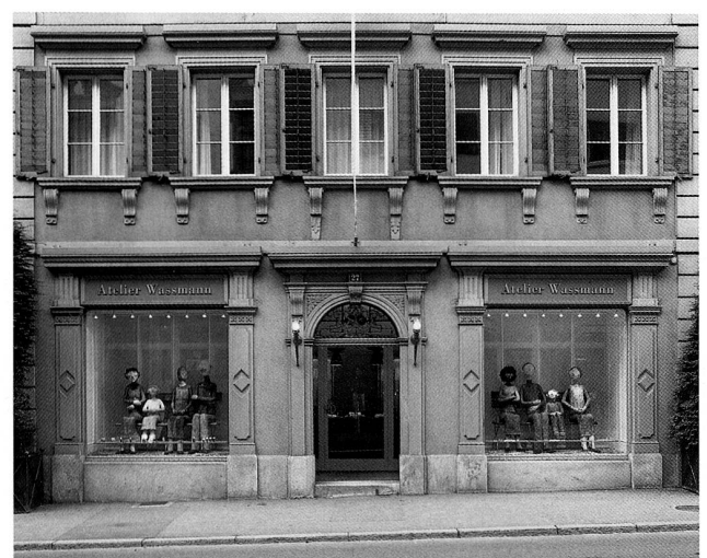
Abb. 4 Haus Neugasse 27 mit Ladeneingang und zwei Schaufenstern im Neurenaissancestil. Das rechte Fenster wurde erst 1927, das schon bestehende Fenster kopierend, ergänzt.
