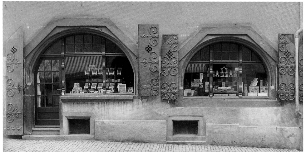
Abb. 2 Die zwei südlichen Fenster der Ostfassade des «Grosshauses» am Kolinplatz 2 vor deren Öffnung im Zuge des Arkadeneinbaus 1970.
