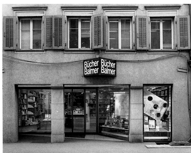
Abb. 5 Haus Neugasse 12 mit zum Teil zugebauter Arkade.
