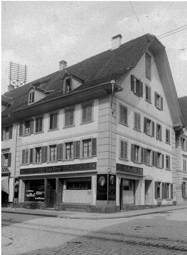
Abb. 7 Haus Neugasse 13 nach dem Ladeneinbau von 1912/13.
