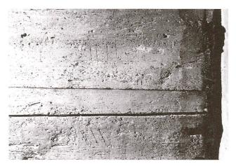
Abb. 33 **Zug, Oberwil, Artherstrasse 128.** Erdgeschoss, Nordostraum, Westwand. Blick Richtung Westen. Kerben als Nummerierungszeichen an den Kanthölzern des Blockbaus.
