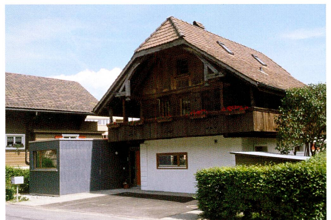
Abb. 21 Unterägeri, Alte Landstrasse 59, Wohnhaus mit Anbau. Ansicht von Nordwesten.
