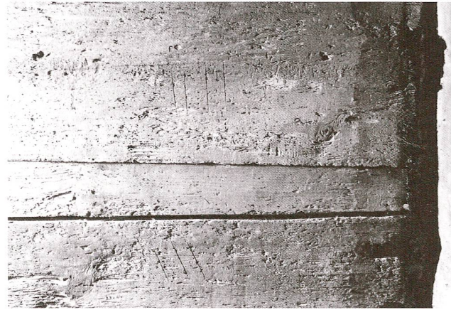
Abb. 33 Zug, Oberwil, Artherstrasse 128. Erdgeschoss, Nordostraum, Westwand. Blick Richtung Westen. Kerben als Nummerierungszeichen an den Kanthölzern des Blockbaus.
