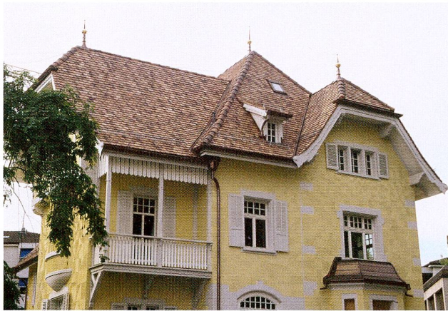
Abb. 9 Cham, Schulhausstrasse 10, «Doktorhaus». Ansicht von Süden.
