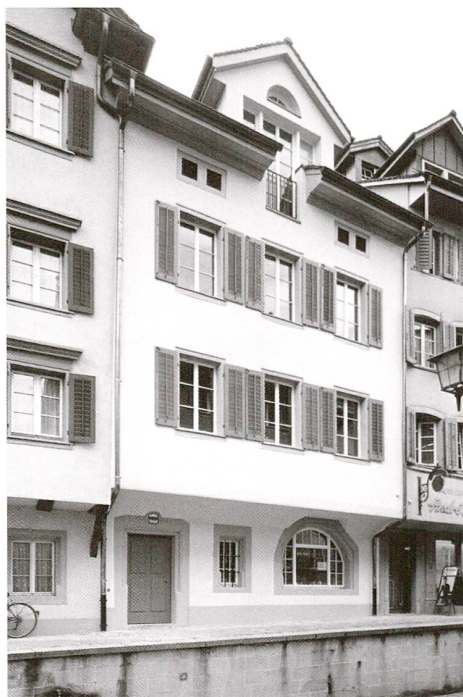
Abb. 27 Zug, Grabenstrasse 22, Pfrundhaus St. Jakob. Ansicht Oberaltstadt.
