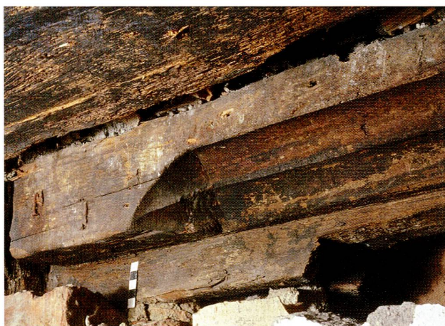
Abb. 13 Baar, Rathausstrasse 6/8. Raum 1. Detailansicht des profilierten Deckenrähms (69) im Raum 1 (Phase 2). Blick Richtung Osten.
