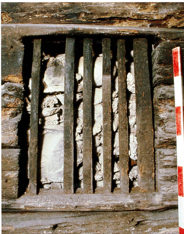
Abb. 17 Baar, Rathausstrasse 6/8. Raum 5. Einbau eines neuen Fensters (88) mit ca. 4 cm breiten Spalthölzern als Vergitterung (Phase 3). Das Fenster wurde in Phase 4 wieder zugesetzt. Blick Richtung Süden.
