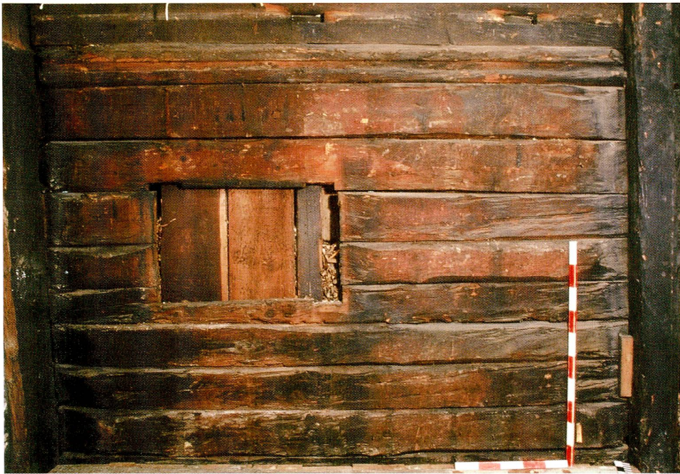
Abb. 14 Baar, Rathausstrasse 6/8. Raum 15. Südwand (18) von innen mit originalem Fenster (87). Die seitlichen Fensterpfosten wurden beim Schliessen des Fensters (Phase 4) entfernt. Sichtbar ist auch die Wandkonstruktion mit relativ grob bearbeiteten, breiten Bohlen, die seitlich auf die schmaleren Ständernuten verschmälert wurden. Oben erkennt man zudem das Wandrähm mit horizontaler Nut für die Deckenbretter.
