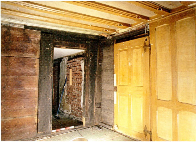
Abb. 18 Baar, Rathausstrasse 6/8. Raum 2. Links die ehemalige Aussenwand (18, Phase 2), in der Mitte die später eingebaute Türe (59, Phase 4), rechts die östliche Zimmerwand (23, Phase 3) und oben die profilierte Balkendecke (Phase 3). Blick Richtung Nordosten.
