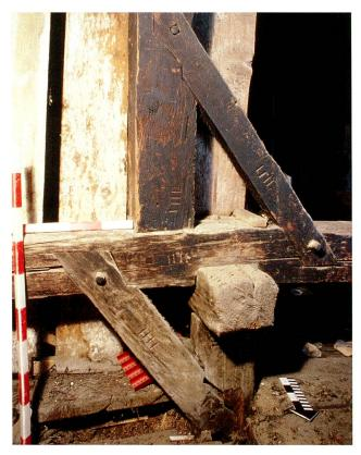
Abb. 23 Baar, Rathausstrasse 6/8. Dachgeschoss, viertes Stuhljoch. Übergang der Stockwerkkonstruktion des zweiten Obergeschosses zur Dachkonstruktion mit Abbundzeichen «IIII». Blick Richtung Süden.
