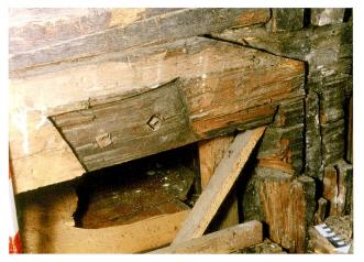
Abb. 9 Baar, Rathausstrasse 6/8. Raum 27. Negativ der Dachschräge des spätmittelalterlichen Kernbaues (Phase 2), das sich im zweiten Obergeschoss erhalten hatte. Blick Richtung Südwesten.
