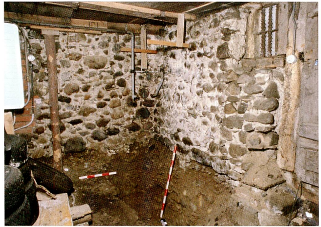
Abb. 10 Baar, Rathausstrasse 6/8. Keller unter Raum 5. Mauerwerk (118) mit originalem Eingang und Kellerfenster (Phase 2). Blick Richtung Nordosten.
