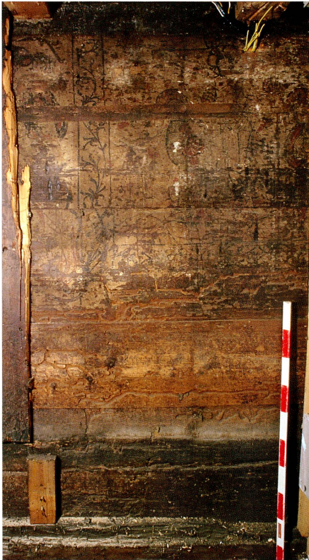
Abb. 12 Baar, Rathausstrasse 6/8. Raum 1, Südwand. Wandmalereien (75) unmittelbar nach ihrer Entdeckung. Erkennbar sind die angeschnittene Figur des Landsknechts (links) und die Kreuzigung Christi (rechts).
