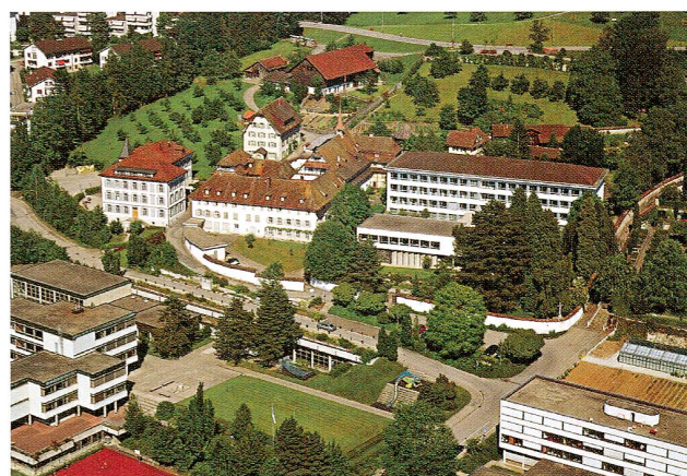
Abb. 15 Kloster Maria Opferung in Zug, 1999. Das moderne Institutsgebäude (1960) und der vorgelagerte Eingangstrakt mit Kirche, Aufenthaltsraum, Speisesaal und Theatersaal am Platz des alten Pensionats.
