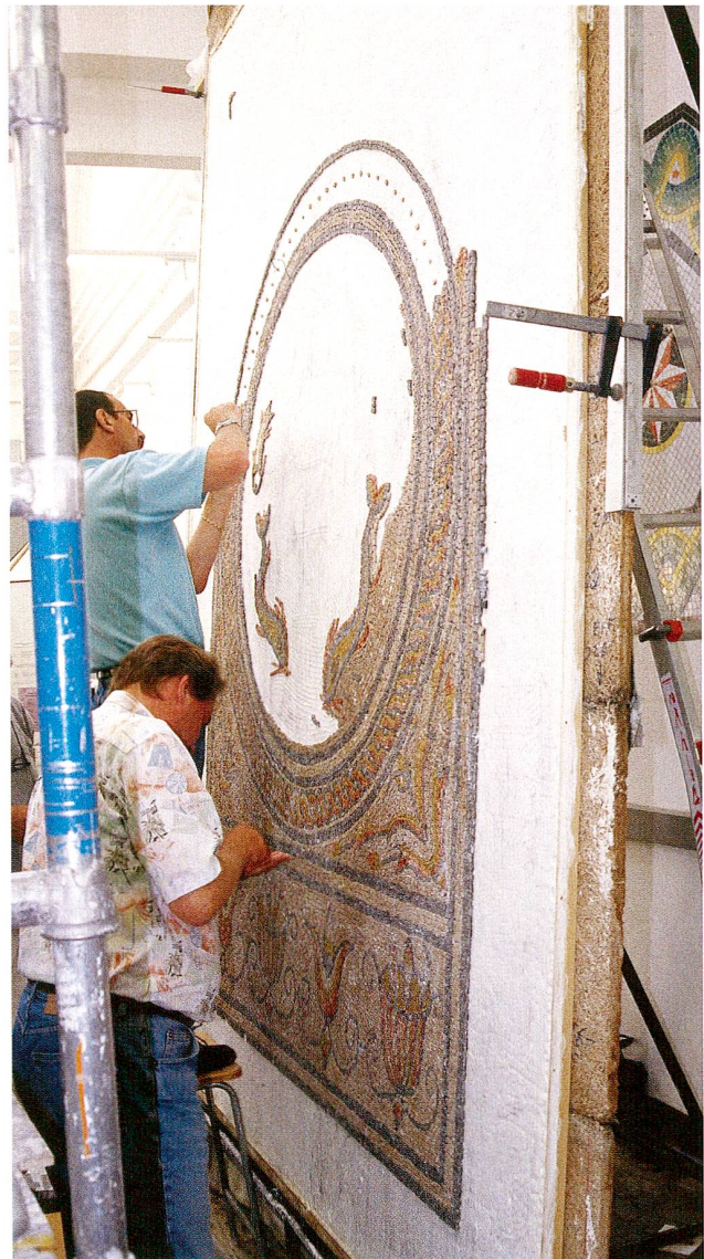
Abb. 5 Die Vorzeichnung ist auf den Untergrund aus feuchtem Kalk übertragen. Nun wird mit dem Setzen der Steine begonnen. Gut sichtbar das Gestell, das die Unterlage trägt.
