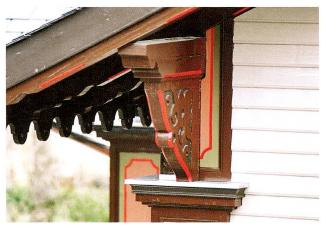
Abb. 5 Cham, Luzernerstrasse 35–41, «Kolonialstilhäuser». Eckkonsole im Dachbereich, nach der Restaurierung.
