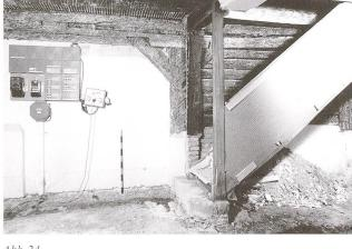
Abb. 24 Zug, Grabenstrasse 22. Trennwand zum Nachbarhaus Grabenstrasse 20, Ständerkonstruktion. Blick Richtung Nordosten.
