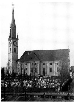
Abb. 16 Cham. Pfarrkirche St. Jakob. Bei der Renovation von 1904/05 behielt man das System der Fassadengliederung bei, gab ihm aber durch rauhen Verputz der Felder und stärkere Farbabstufungen eine kontrastreichere, neubarocke Wirkung.
