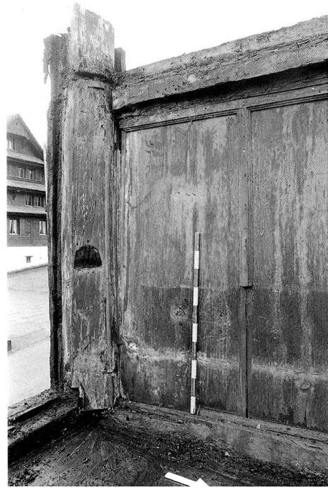
Abb. 25 Hünenberg, Dorfstrasse 8/10. Lehmfachwerk in der Ostfassade, Erdgeschoss.
