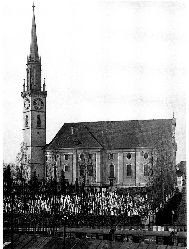
Abb. 16 Cham. Pfarrkirche St. Jakob. Bei der Renovation von 1904/05 behielt man das System der Fassadengliederung bei, gab ihm aber durch rauhen Verputz der Felder und stärkere Farbabstufungen eine kontrastreichere, neubarocke Wirkung.
