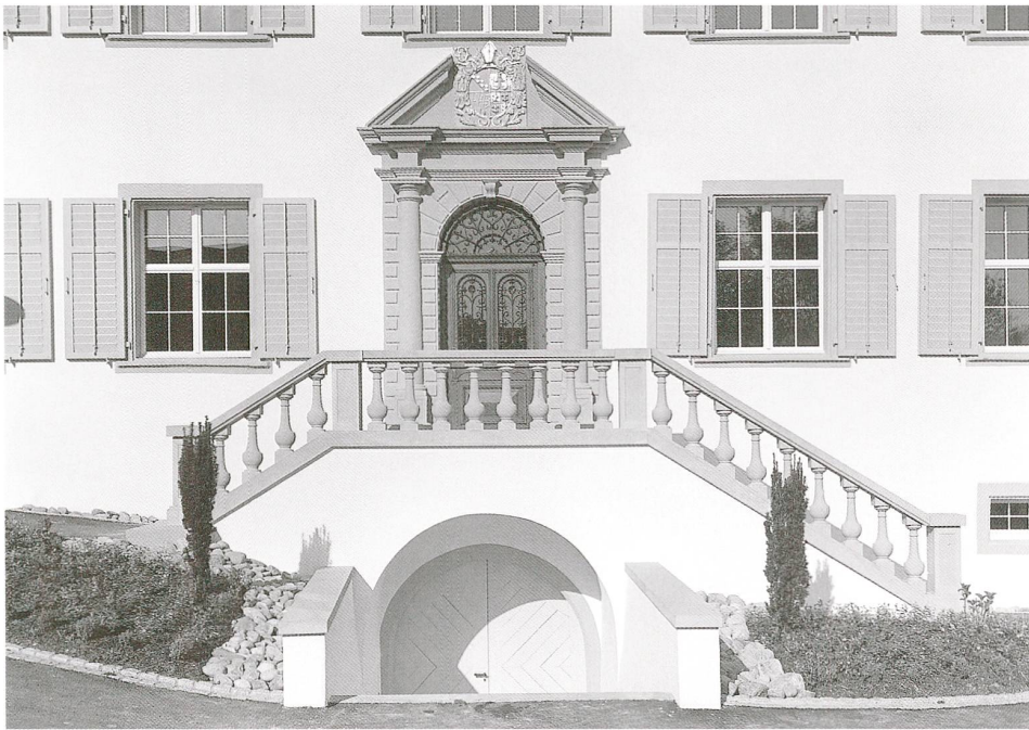
Abb. 10 Baar, Walterswil, Wettingerhaus. Haupteingang. Nach der Restaurierung, 2001.
