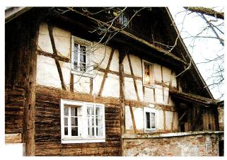
Abb. 13 Cham, Ochsenlon. Ostfassade mit jüngerem Riegelwerk. Ende 2001.
