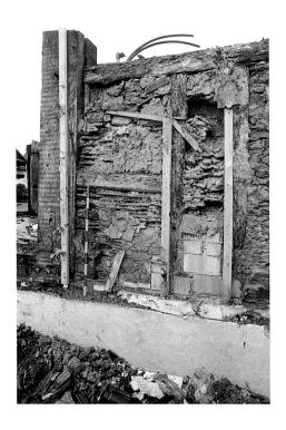
Abb. 25 Hünenberg, Dorfstrasse 8/10. Lehmfachwerk in der Ostfassade, Erdgeschoss.
