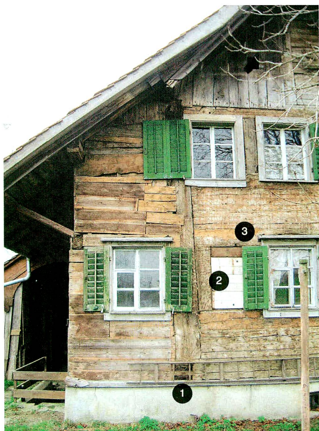
Abb. 14 Cham, Ochsental, Westfassade. 1 Schwellenschlösser des Kernbaues von 1681. 2 Reste der ursprünglichen Befensterung. 3 Loch für das Bedienungsband des Klappladens, mit dem man das Fenster verschloss.
