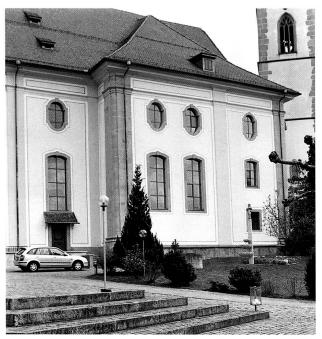
Abb. 18 Cham. Pfarrkirche St. Jakob. Bei der Aussenrestaurierung von 2001 erhielten die Fassaden ihr verlorenes, ursprüngliches Farbkleid zurück. Es wurde nach dem Bilddokument von 1872 und aufgrund von bekannten Aussenfassungen auf Originalplänen und Bauten des Baumeisters Jakob Singer rekonstruiert.
