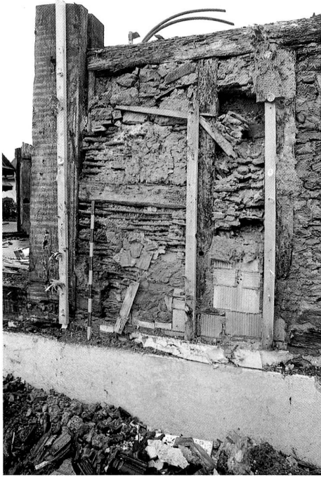
Abb. 25 Hünenberg, Dorfstrasse 8/10. Lehmfachwerk in der Ostfassade, Erdgeschoss.
