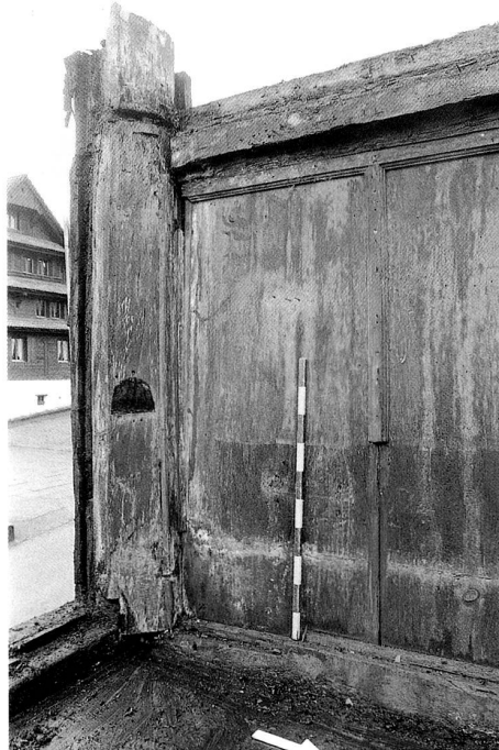
Abb. 25 Hünenberg, Dorfstrasse 8/10. Lehmfachwerk in der Ostfassade, Erdgeschoss.
