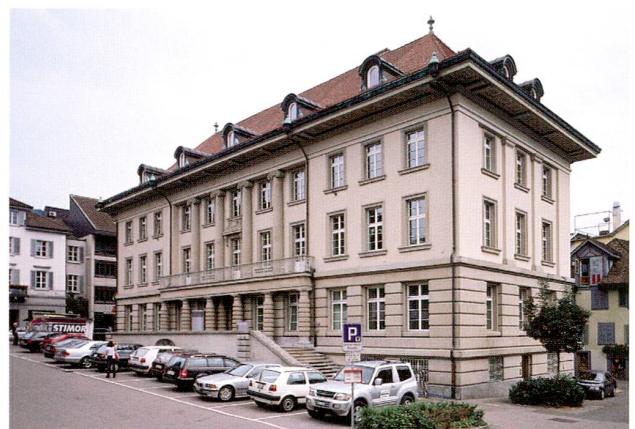
Abb. 36 Zug, Postplatz, Verwaltungsgebäude.
