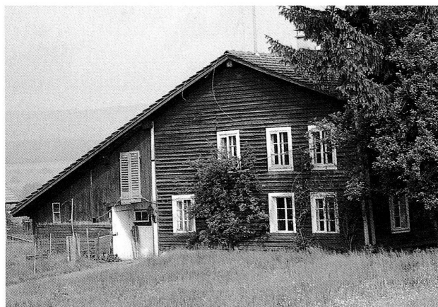
Abb. 19 Hünenberg, Burgstrasse 18. Strassenseitige Hauptfassade und neuere Anbauten an den Seitenfassaden. Blick Richtung Norden, Mai 2000.
